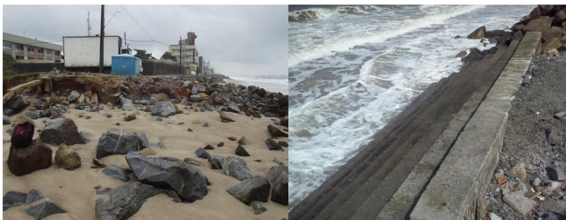
Figura 37: Enrocamentos em mau estado de conservação (à esquerda); e escadarias de menor porte, ambos localizados no Balneário Riviera.
