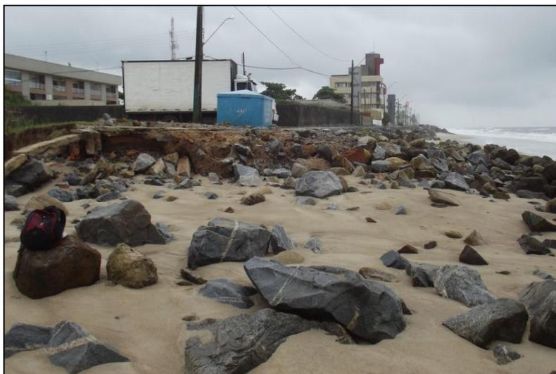
Figura 6: Enrocamentos destruídos pela ação do mar na Praia de Matinhos- PR, exemplo de falta de manutenção periódica de obras costeiras (Fonte: A autora, 2016).
