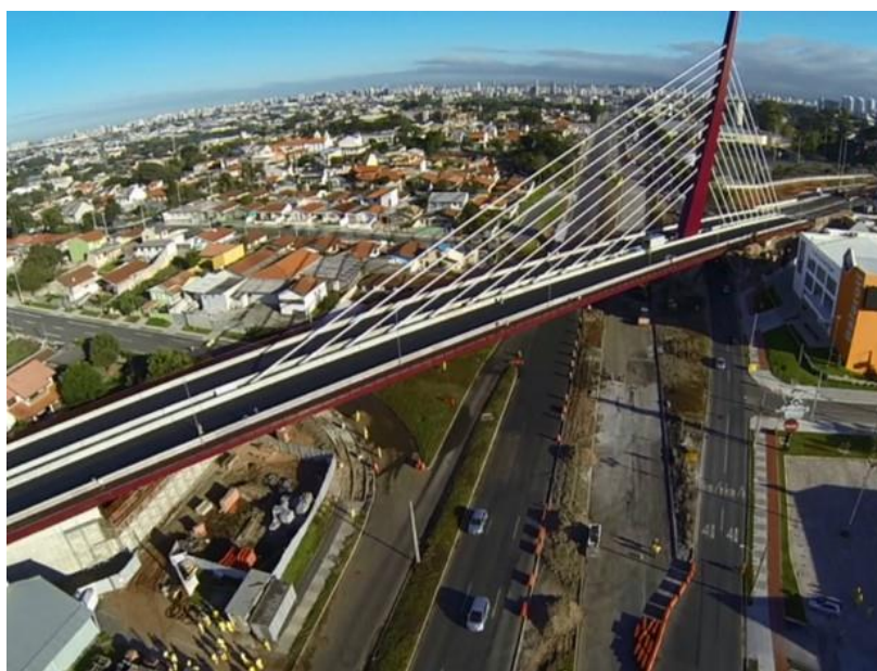
FIGURA 15 – Viaduto Estaiado de Curitiba
