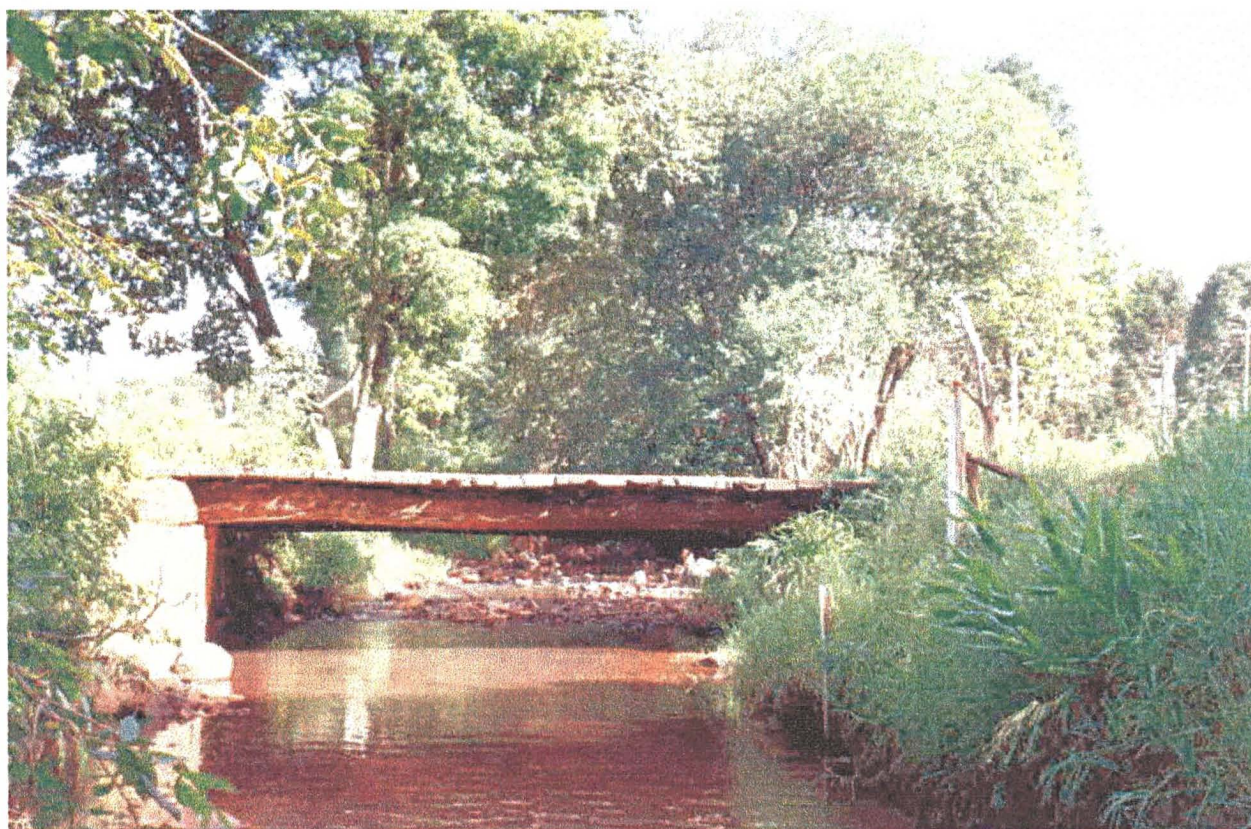
Foto 06 - Estação Pinhal, ângulo de visada de jusante para montante.
