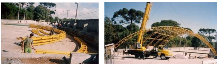
FIGURA 29 - OBRAS NO CESC FONTE: www.colegiosantacandida.com.br
