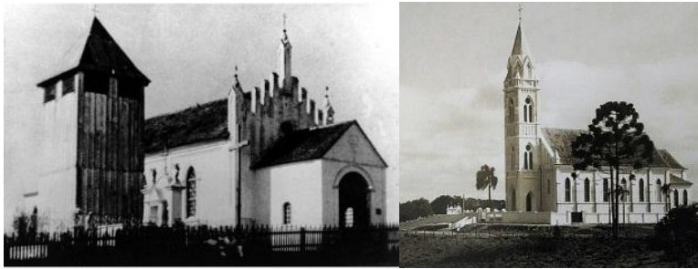
FIGURA 13 - PRIMEIRA (1877) E ATUAL ARQUITETURA DA IGREJA DE SANTA CÂNDIDA (FOTO DE 1956)
