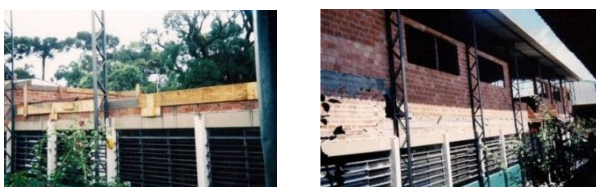
FIGURAS 36 - OBRAS DE CONSTRUÇÃO DO AUDITÓRIO DO CESC FONTE: www.colegiosantacandida.com.br
