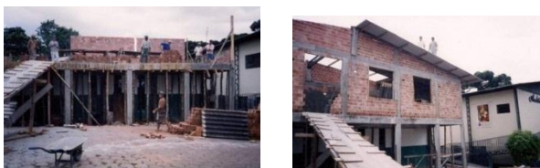
FIGURA 43 - CONSTRUÇÃO DO REFEITÓRIO
