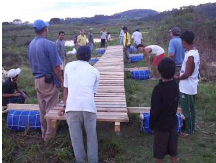
Figura 2. Passarela de madeira.
