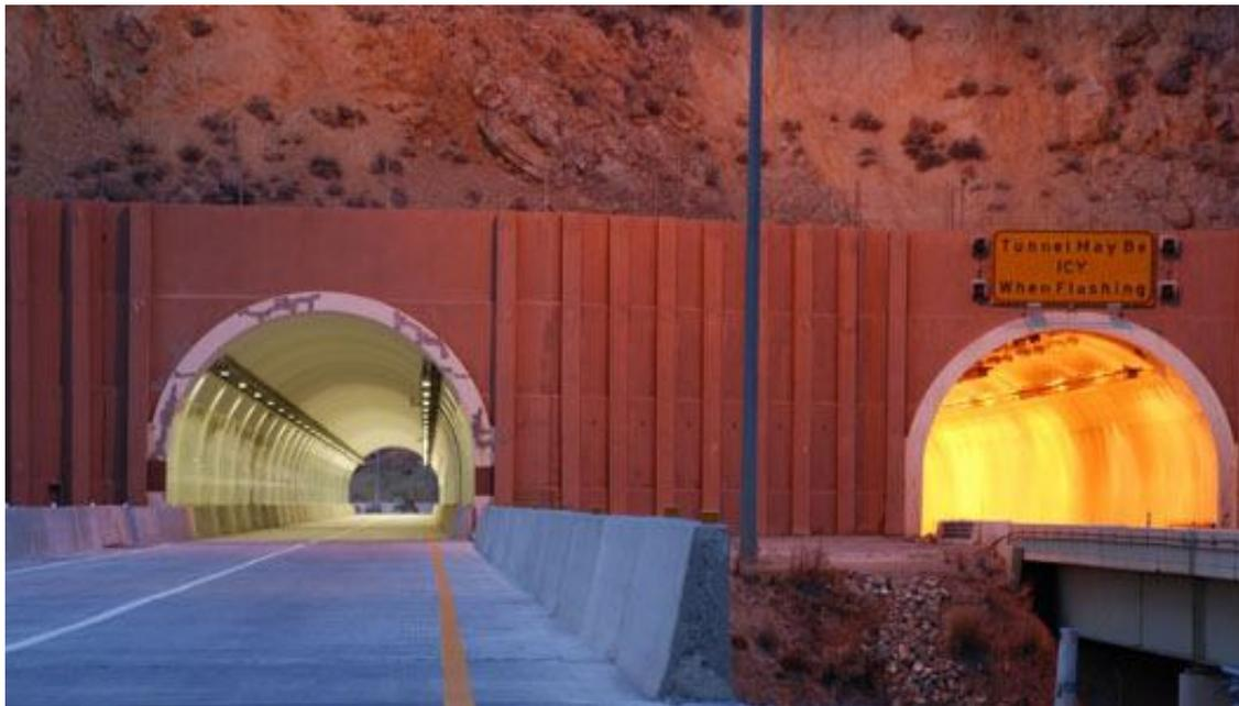
Figura 4 - Exemplo de túnel que utiliza o sistema de iluminação a LED (lado esquerdo), em comparação a um túnel que não utiliza (lado direito)
