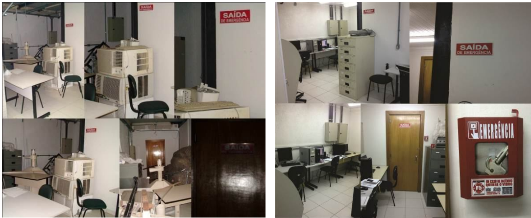
(a) Saída de emergência obstruída
