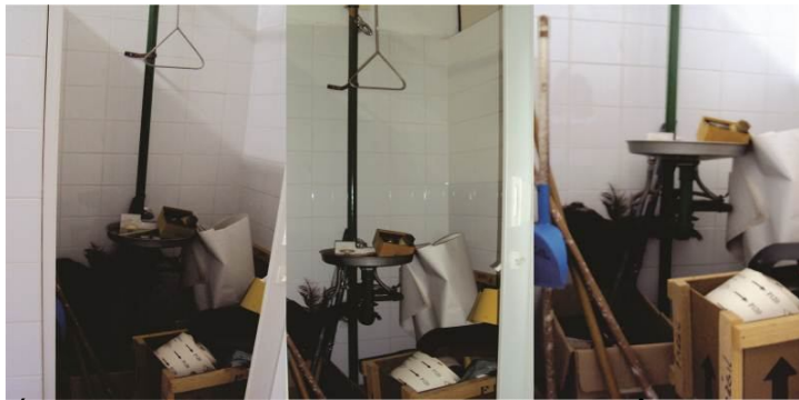
FIGURA 17 – DEPÓSITO NO ESPAÇO DO CHUVEIRO DE EMERGÊNCIA E LAVA-OLHOS
