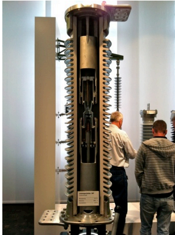
Figura 3. Ilustração do corte longitudinal da câmara de extinção de arco de um disjuntor de alta tensão. Fonte: O autor, 2012.
