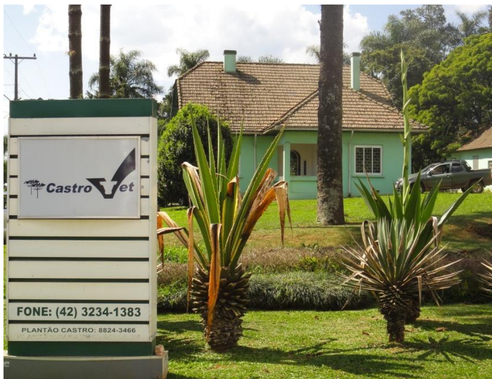
Figura 7: Vista frontal da sede da empresa Castrovet Assistência Veterinária, Castrolanda, Castro/PR.
