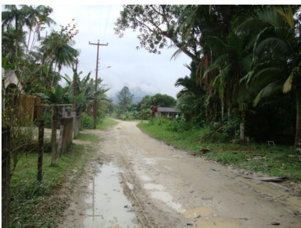
FOTO 11 – ESTRADA DA COMUNIDADE FONTE: os autores (2013).
