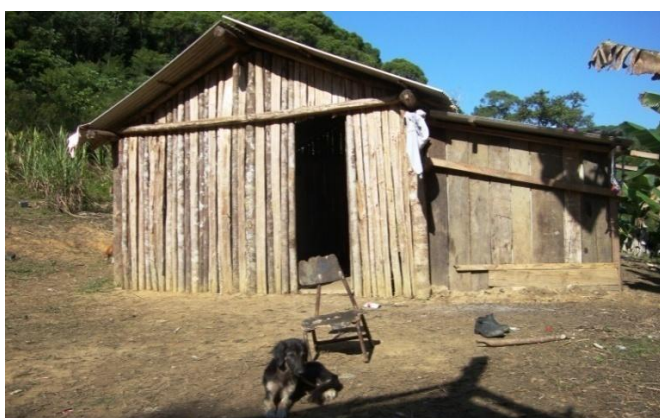
FOTO 6 - CASA DE PAU-A-PIQUE NA ALDEIA GUARANI KUARAY GUATÁ PORÃ FONTE: os autores (2013).
