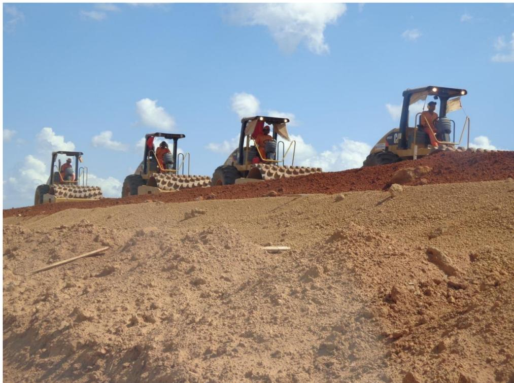
Foto 14 - Máquinas trabalhando na BR-429 para posterior asfaltamento.
