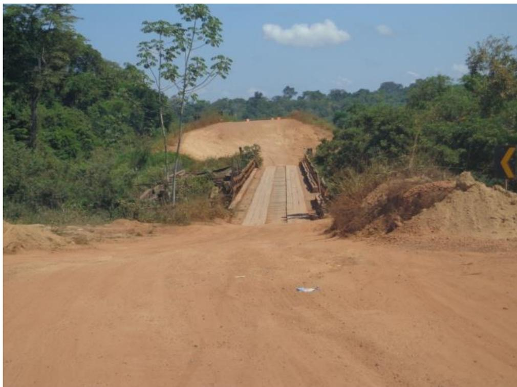
Fotos 13 – Visualização de ponte de madeira e altura de aterramento do Trecho da BR-429 para seu asfaltamento.
