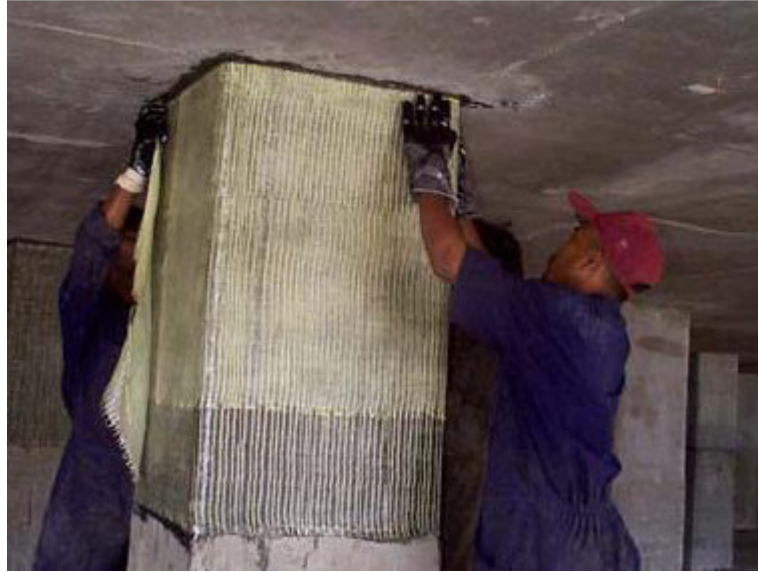
Figura 21 – Aplicação de manta de CFRP em um pilar.
