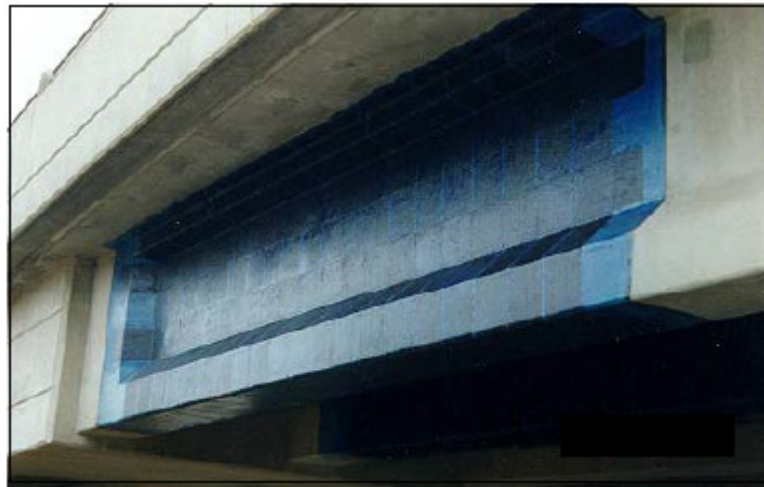
Figura 20 – Aplicação do CFRP em reforço de longarina de uma ponte.
