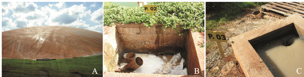
FIGURA 4 - (A) Biodigestor (B) Entrada do biodigestor (C) Saída do biodigestor
