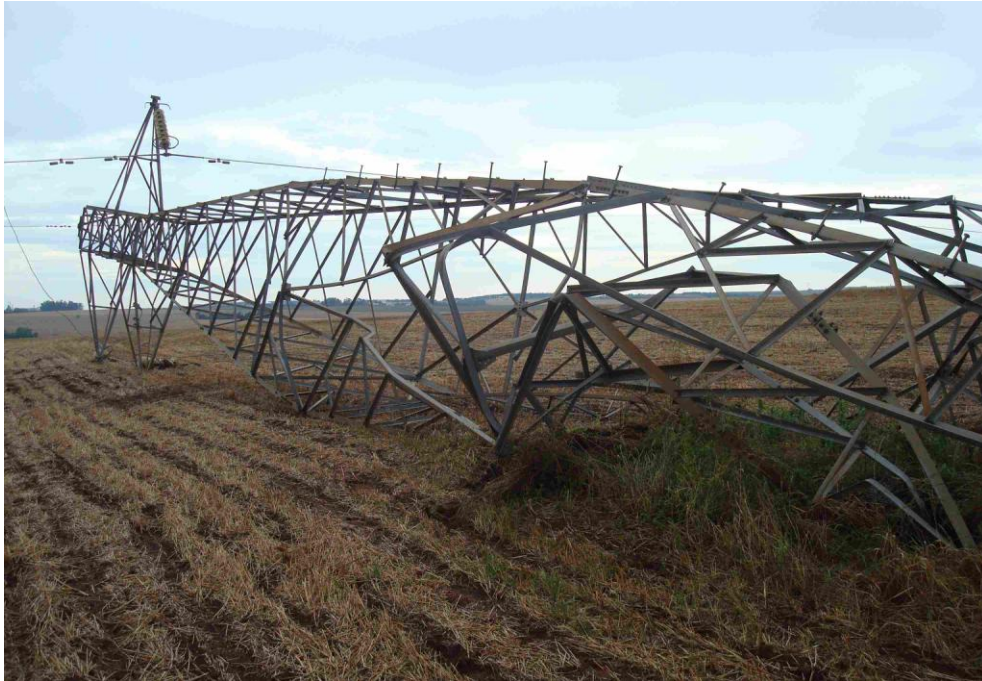
FIGURA 3.7 – QUEDA DA ESTRUTURA 34 DA LT MEDIANEIRA – CÉU AZUL FONTE: WAZEN 2011
