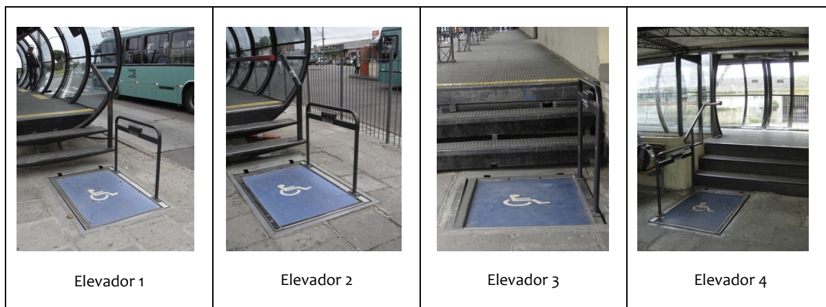
Quadro 3.4 – Fotos dos elevadores instalados no terminal do Capão da Imbuia, desenvolvido pela autora.
