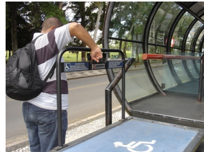
Usuário do sistema de transporte movimentando a plataforma para cima, caso uma PRm precisasse sair da estação-tubo. O jovem L, 23 anos, porteiro, posou como modelo para essas fotos.
