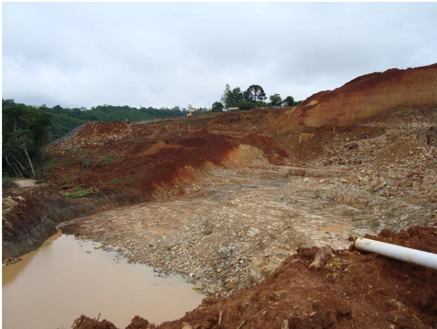
FIGURA 18 - ASPECTO DA ROCHA FRATURADA E EXPOSTA PELAS ESCAVAÇÕES
