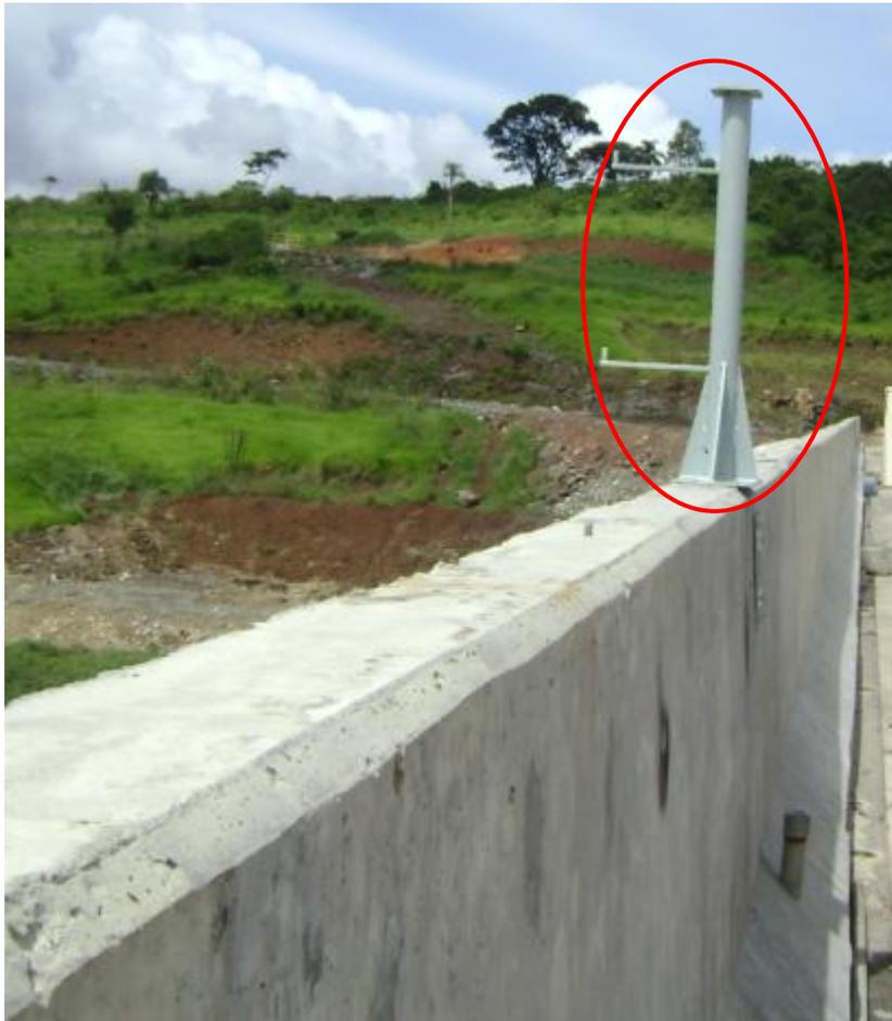
FIGURA 21 – SUPORTE DA ANTENA GNSS FIXADO NA ESTRUTURA DA BARRAGEM
