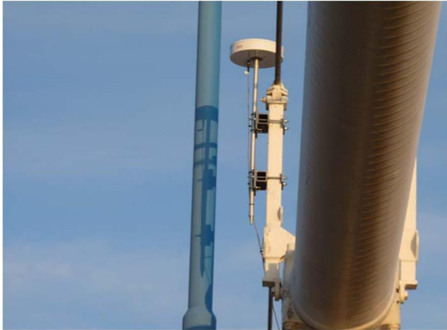
FIGURA 17 - ANTENA AT503 FIXADA AO CABO PRINCIPAL DE SUSPENSÃO DA TRAVESSIA DA PONTE EM SEVERN
