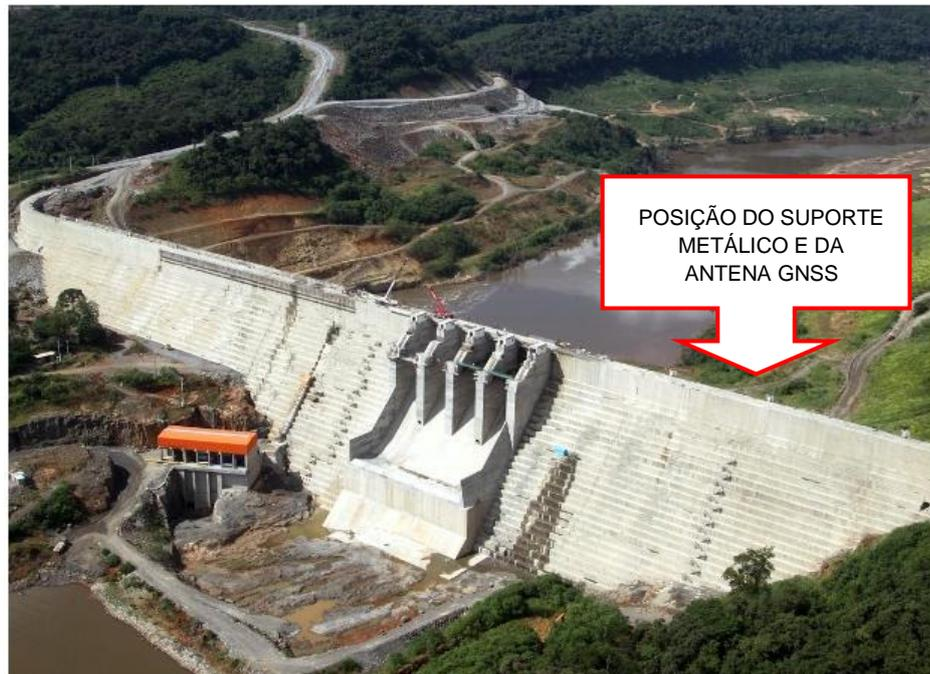
FIGURA 19 - INDICAÇÃO DA POSIÇÃO DO SUPORTE METÁLICO E DA ANTENA GNSS SOBRE A ESTRUTURA DA BARRAGEM
