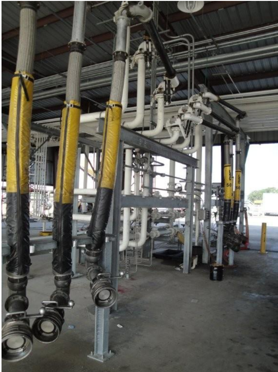
Figura 41 - Apêndice A - Plataforma de carregamento bottom load
