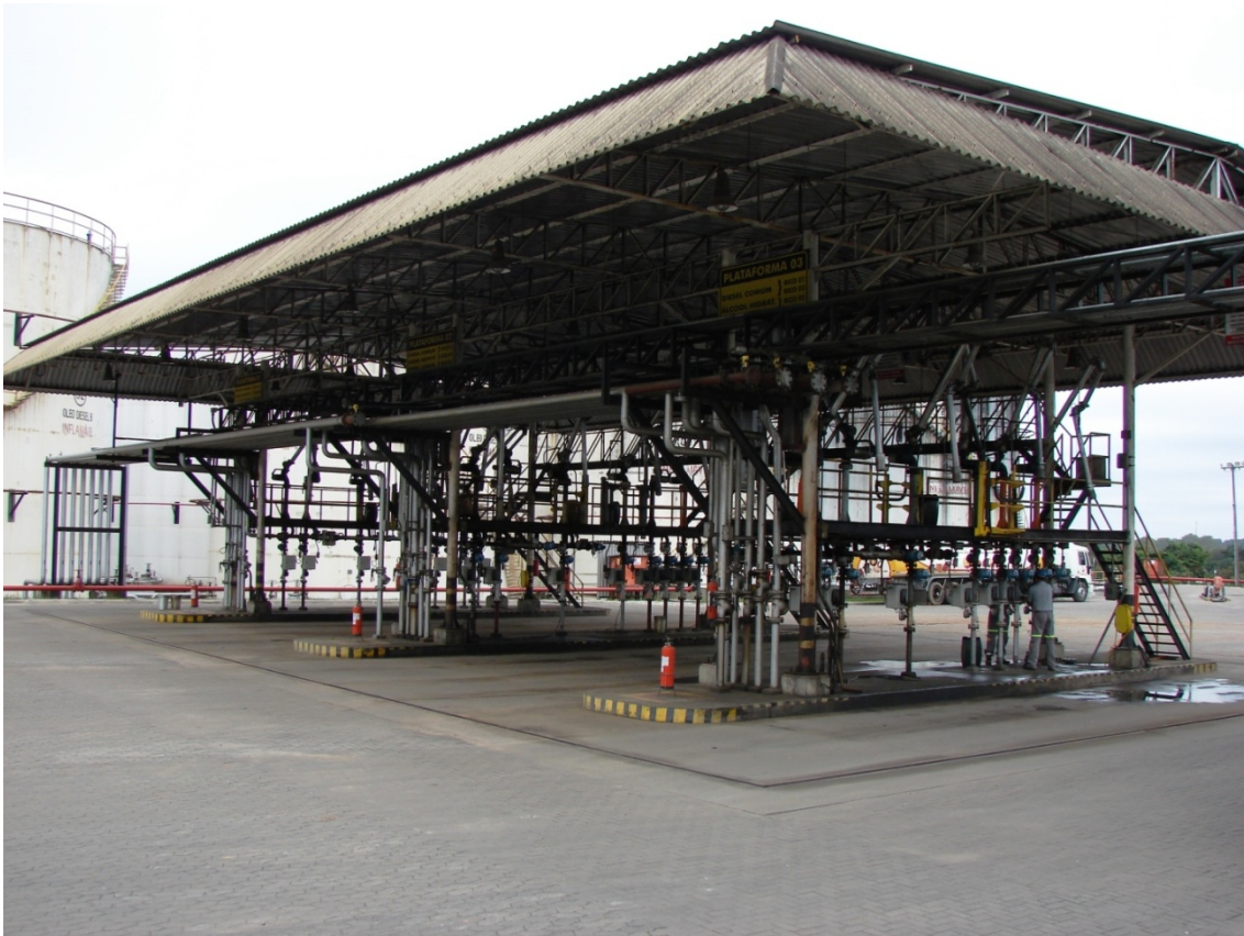
Figura 39 - Apêndice A - Plataforma de carregamento de uma base primária
