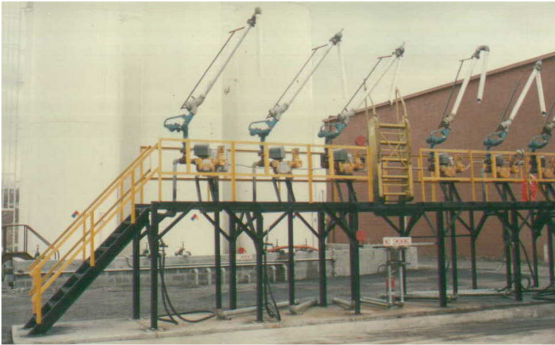
Figura 40 - Apêndice A - Plataforma de carregamento top load
