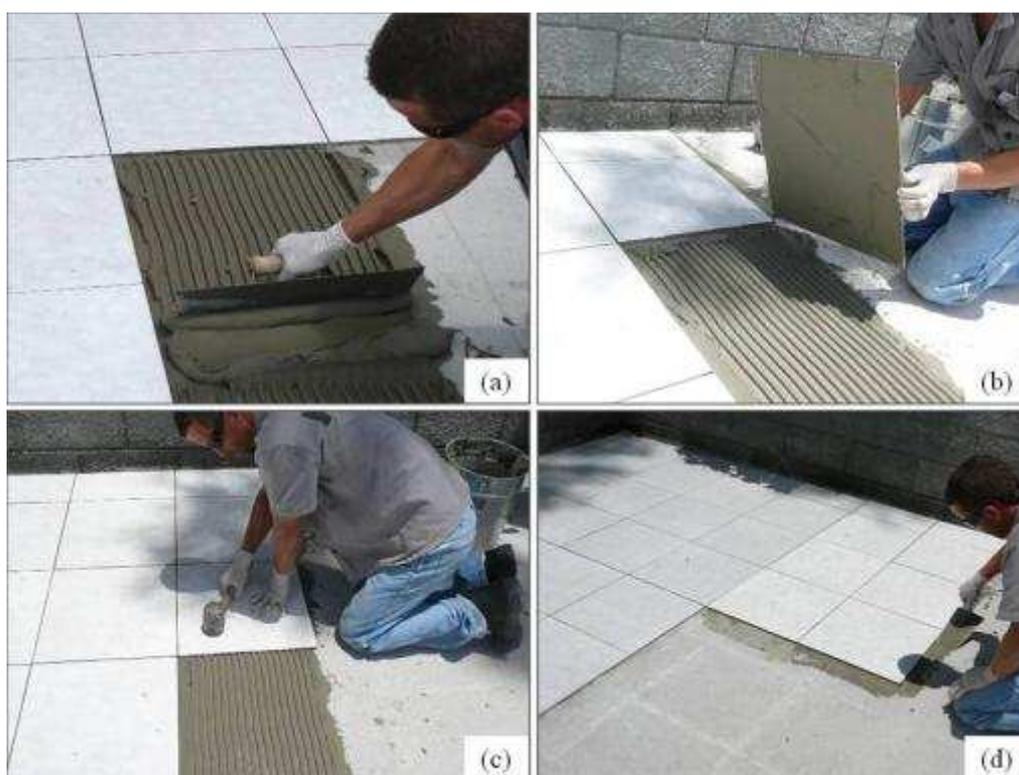
Figura 3: Assentamento de piso sobre piso: (a) Formação dos cordões; (b) Execução de dupla colagem; (c) Amassamento dos cordões e; (d) limpeza das juntas.
