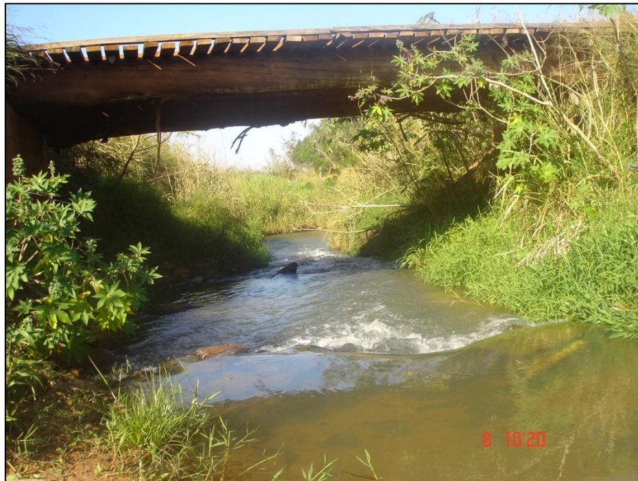
Figura 22 – Ponte sobre o rio Caju em área de pastagem. FERREIRA, S. L. da S. – Julho, 2010.
