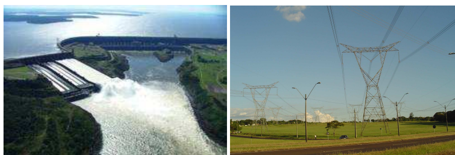
Figuras 33 e 34: Itaipu, a maior hidrelétrica do mundo, e, cabos que levam energia para todo o Brasil. Fonte: Site www.fozdoiguacu.pr.gov.br e Dados da Pesquisa.
