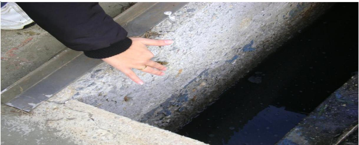
FIGURA 3 – CORROSÃO DO CONCRETO POR AÇÃO DO ÁCIDO SULFÍDRICO
