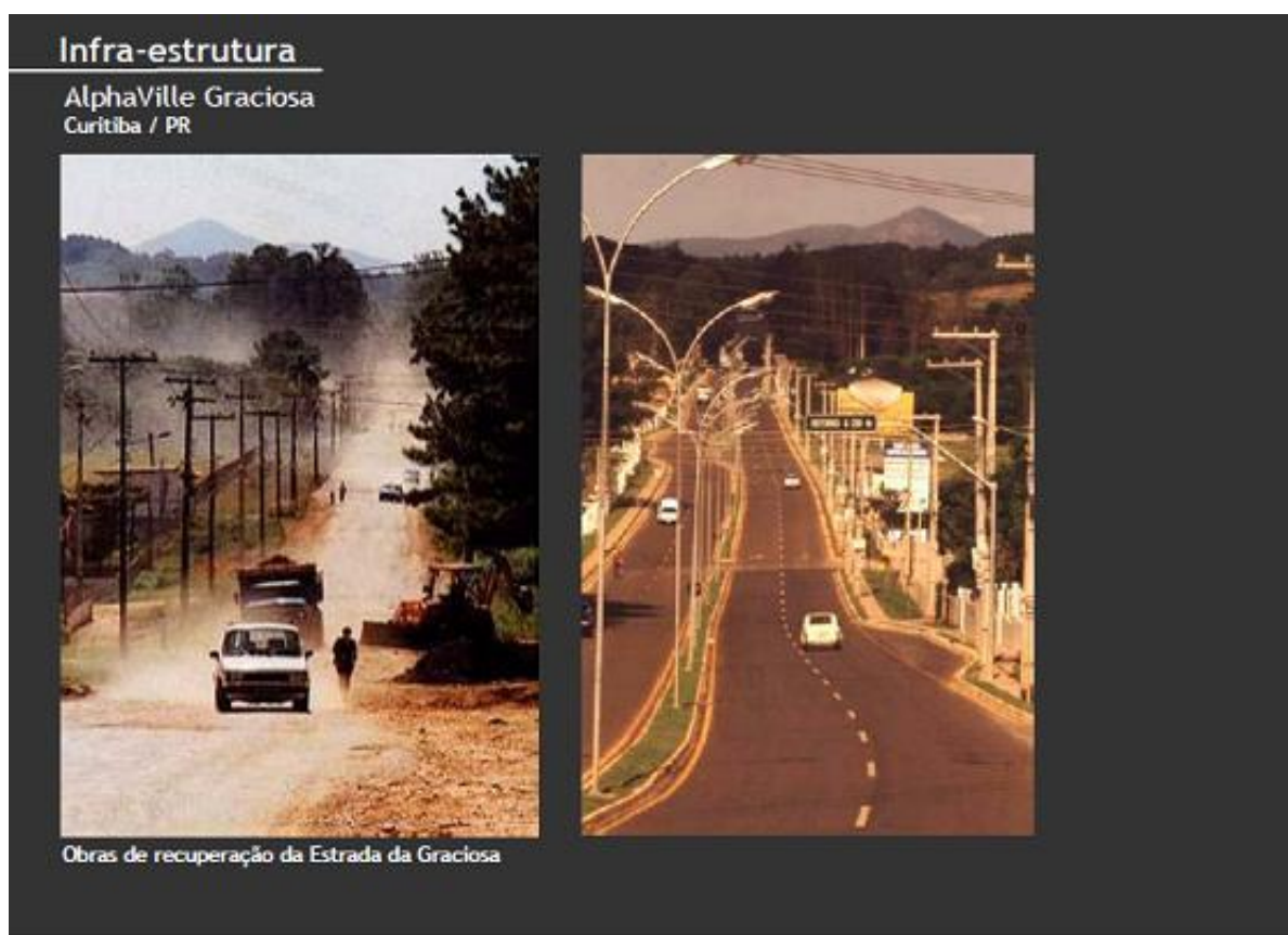
FIGURA 38 – INFRAESTRUTURA CRIADA PARA DAR ACESSO AO COMPLEXO ALPHAVILLE, EM PINHAIS – PR
