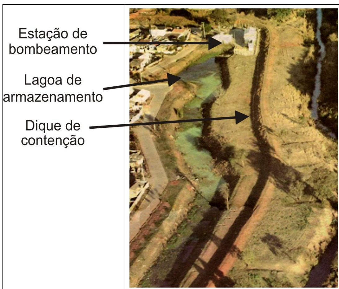
FIGURA 27 – OBRAS REALIZADAS PARA CONTER AS INUNDAÇÕES
