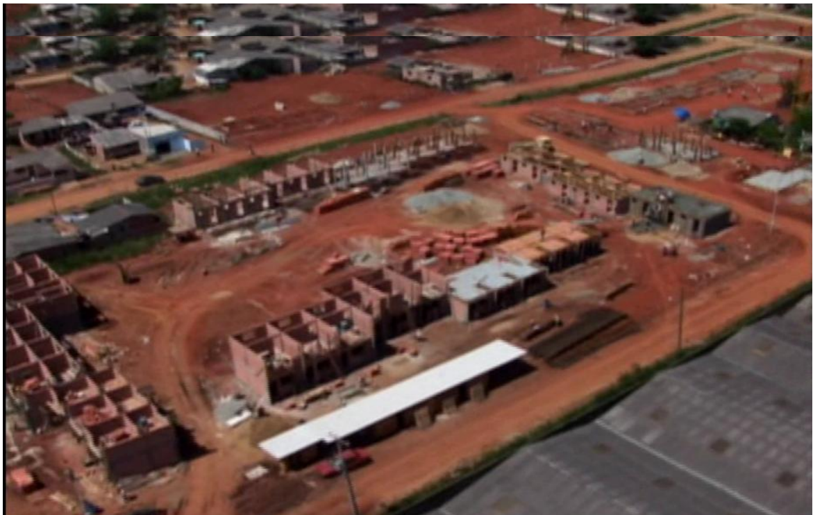
FIGURA 26 – CONSTRUÇÃO DOS SOBRADOS NA PORÇÃO NORTE DA VILA ZUMBI
