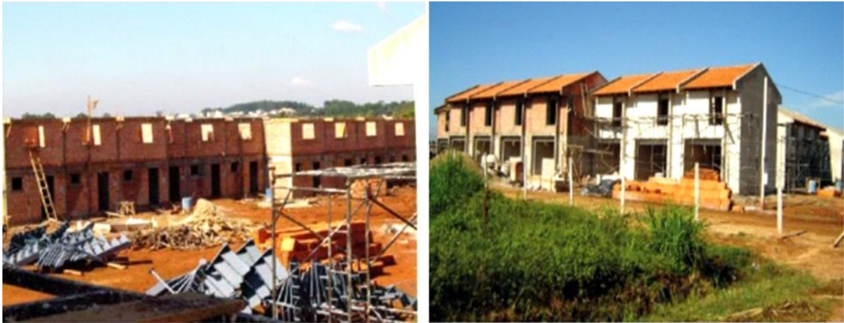
FIGURA 25 – CONSTRUÇÃO DO CONJUNTO DE SOBRADOS NA PORÇÃO NOROESTE DA VILA ZUMBI
