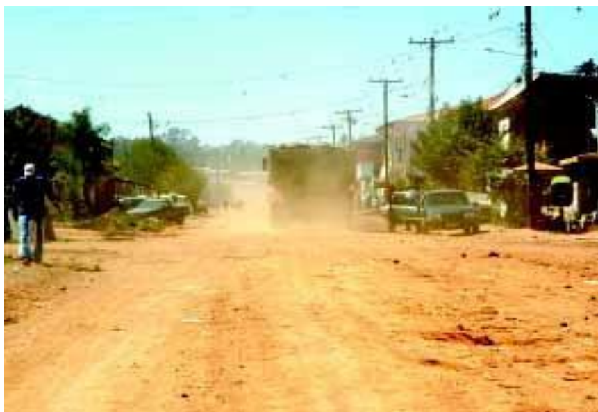
FIGURA 30 – RUA ALEIXO SCHLUGA, EM 2005, ANTES DAS INTERVENÇÕES DO ESTADO
