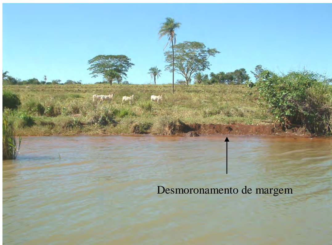
Figura 55: Exemplo de exposição do terreno e favorecimento da erosão na margem, causada pela pecuária e ação de ondas do lago na margem direita do reservatório próximo ao córrego da Flecha.
