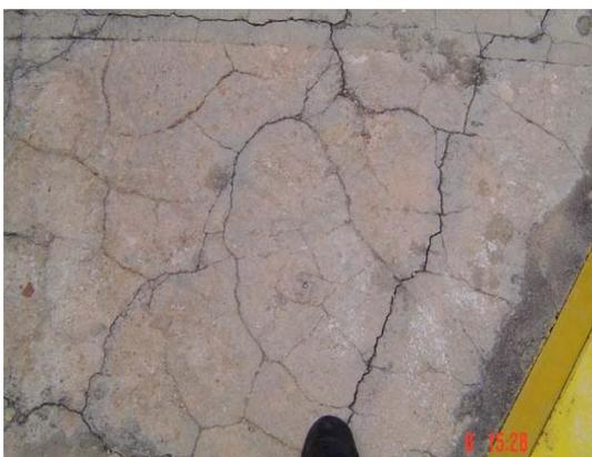
(a) fissuras primárias no piso da tomada d'água da UHE Paulo Afonso III
