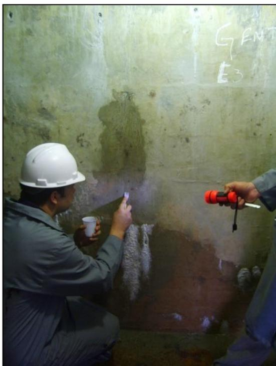
Figura 32 - Coleta de amostra de material exsudado do concreto
