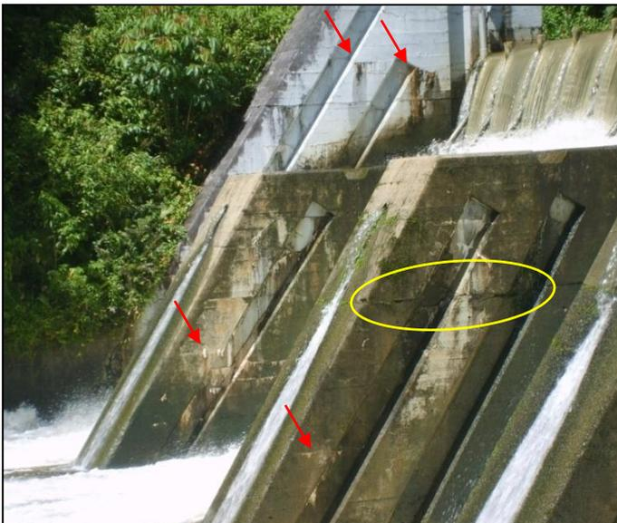
(c) contrafortes do vertedouro apresentando fissura horizontal e exsudação de materiais na superfície
