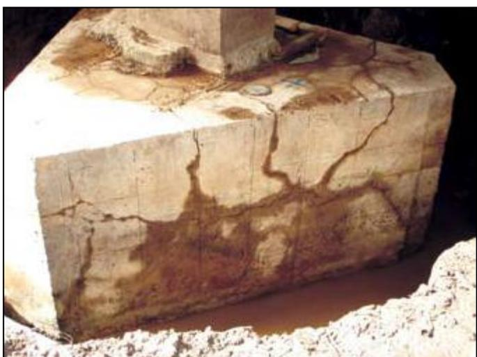
Figura 9 - Fissuras em bloco de fundação afetado pela RAA na cidade de Recife/PE
