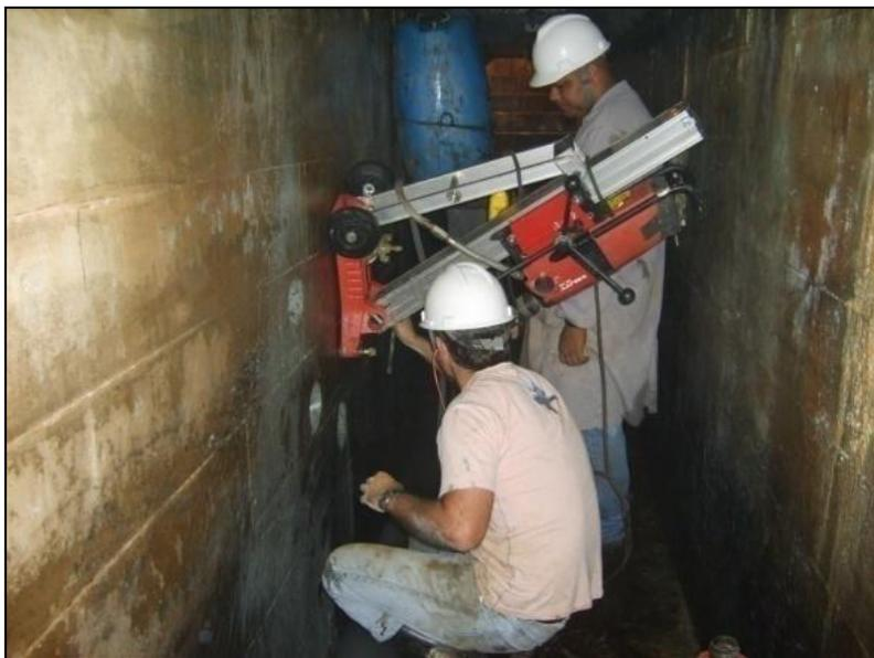
Figura 29 - Extração inclinada nas paredes da galeria
