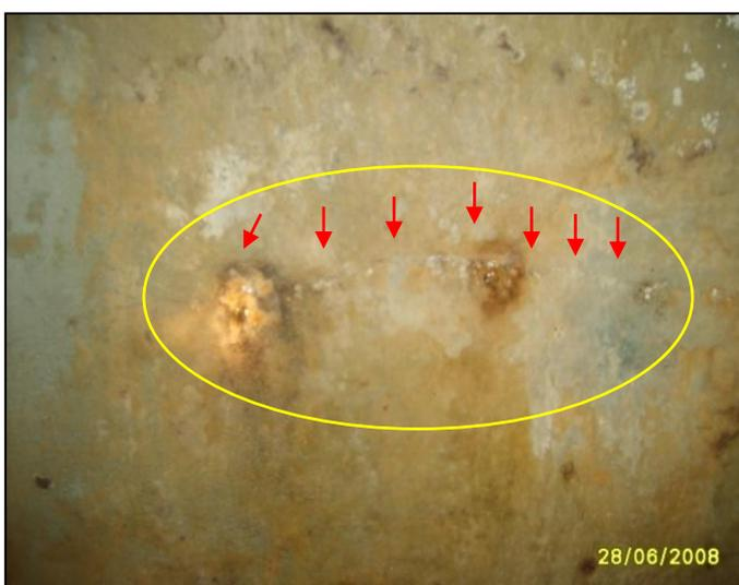
(d) gel exsudado de fissura no interior da galeria de drenagem
