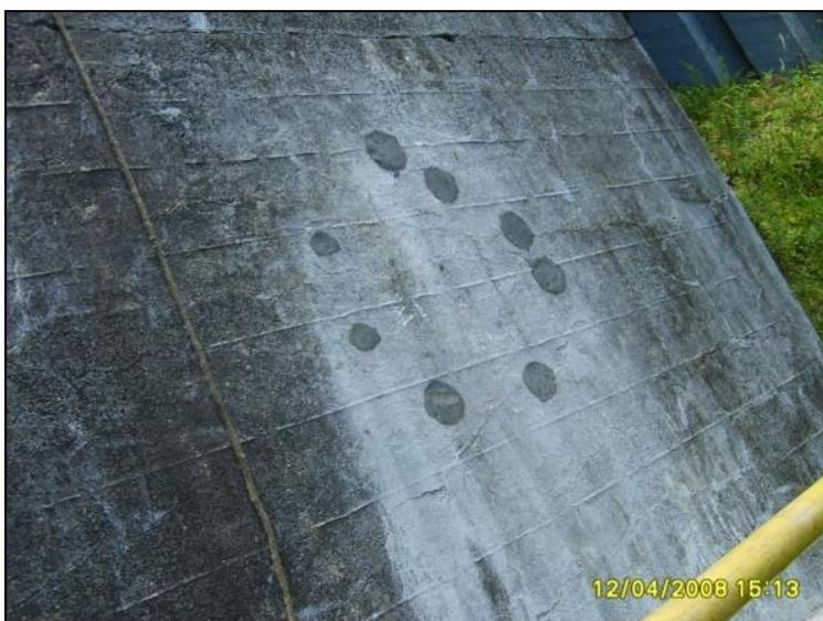
Figura 30 - Furos preenchidos com concreto após extração
