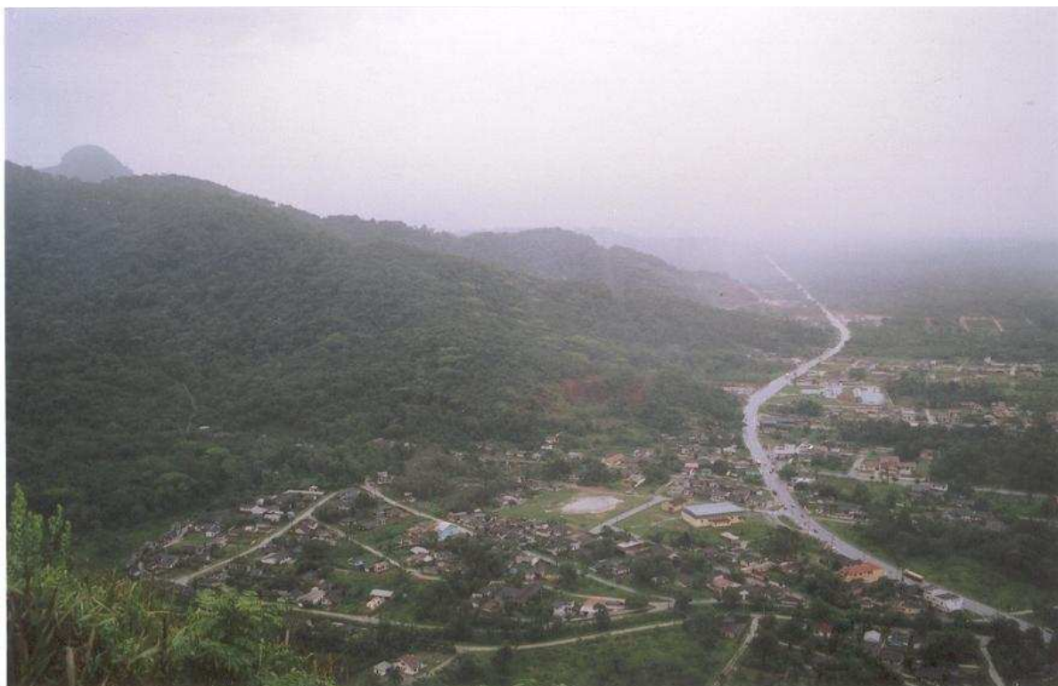
Figura 8 - Bairro Sertãozinho, no município de Matinhos e PR-508 vistos do morro do antigo teleférico mostrando o crescimento desordenado em direção ao PARNÁ Saint-Hilaire/Lange na região de Matinhos
