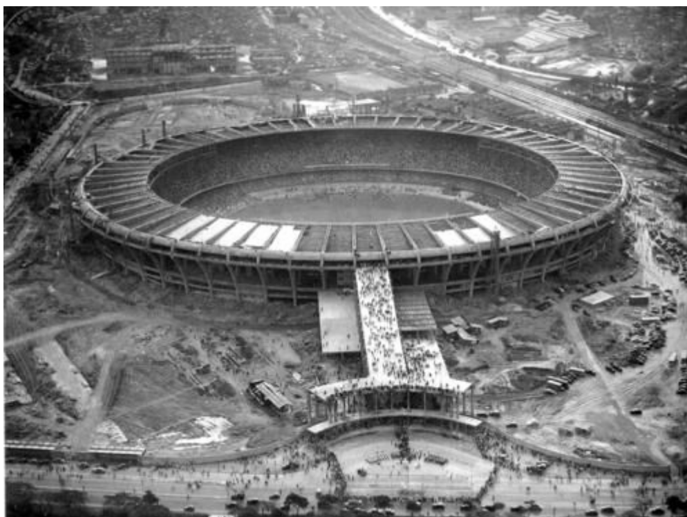
Visão panorâmica do Estádio Mario Filho (Maracanã-1950) e seu entorno. Disponível em www.rio.rj.gov.br . Acesso realizado em 10/01/08.
