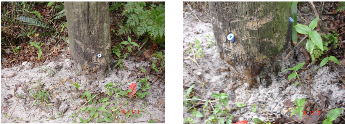
FIGURA 12 - POSTES ATACADOS COM PODRIDÃO MOLE OU PARDA FONTE: A autora (2007)
