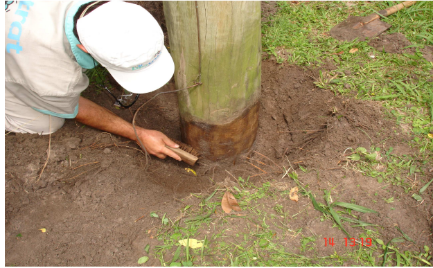
FIGURA 4 - LIMPEZA DO POSTE FONTE: A autora (2007)
