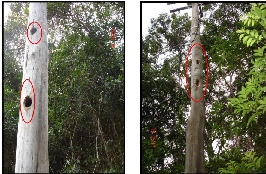
FIGURA 14 - POSTES ATACADOS POR PICA-PAUS FONTE: A autora (2006)
