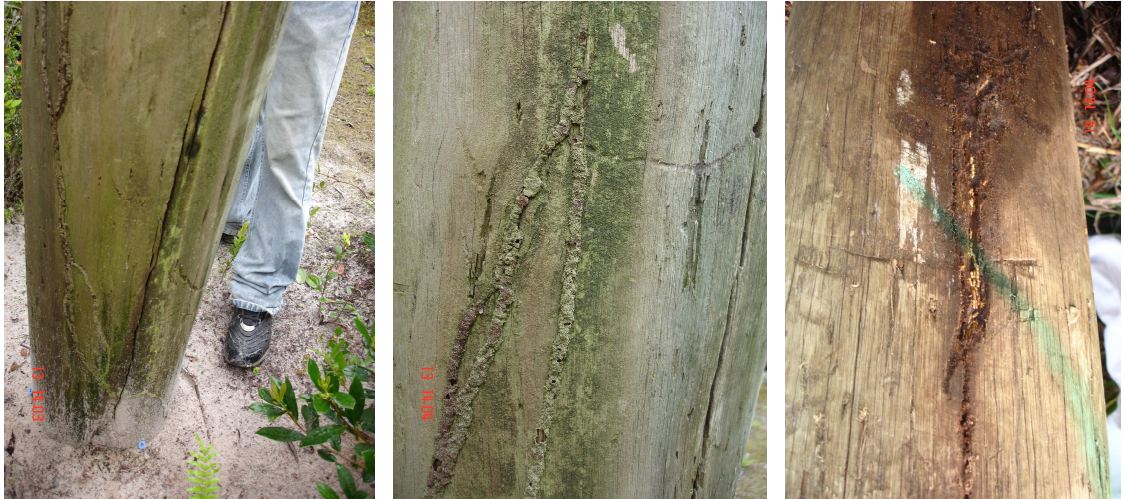
FIGURA 13 - POSTES ATACADOS POR CUPINS DE SOLO FONTE: A autora (2007)
