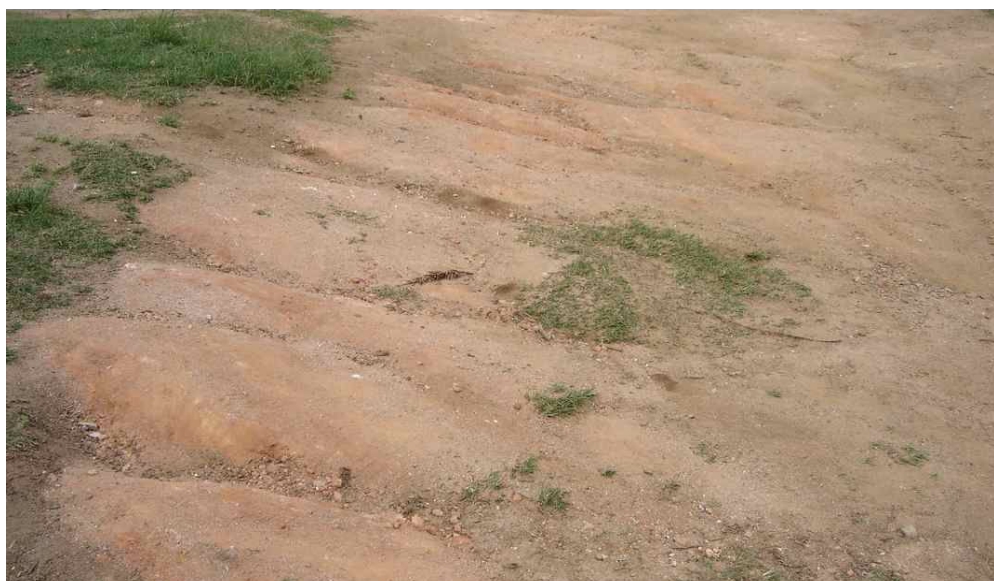
Figura 15 - Início de erosão em sulcos próxima de drenagem
