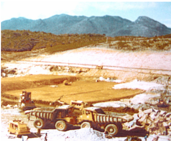
Foto 2 - Construção da Barragem Piraquara I Autoria: Sanepar (1977-78)
