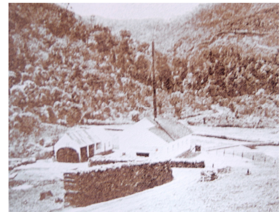
Foto 5 – Chaminé de bombeamento. Autoria: Sanepar (data desconhecida)
