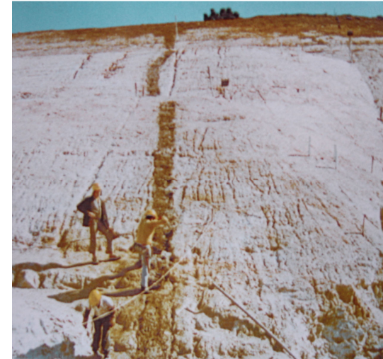
Foto 3 – Construção da Barragem Piraquara I Autoria: Sanepar (1977-78)
