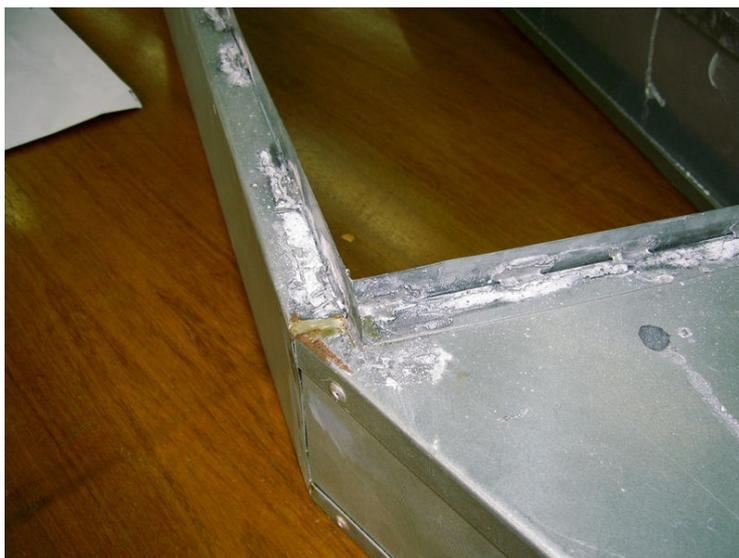
FIGURA 83 – Foto do detalhe da lâmina inferior, junção frente/lateral
