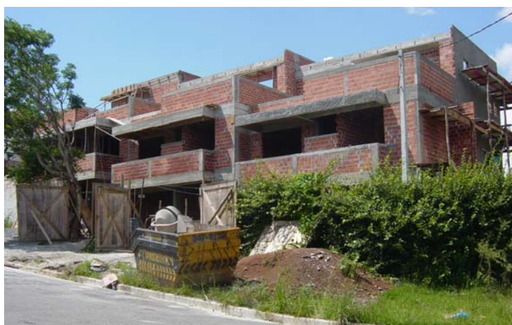
b) Vista da Obra 2
