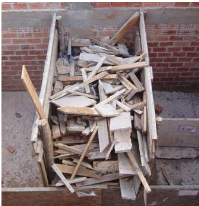
FIGURA 4.7 – MADEIRA ARMAZENADA TEMPORARIAMENTE NO CANTEIRO DA OBRA
