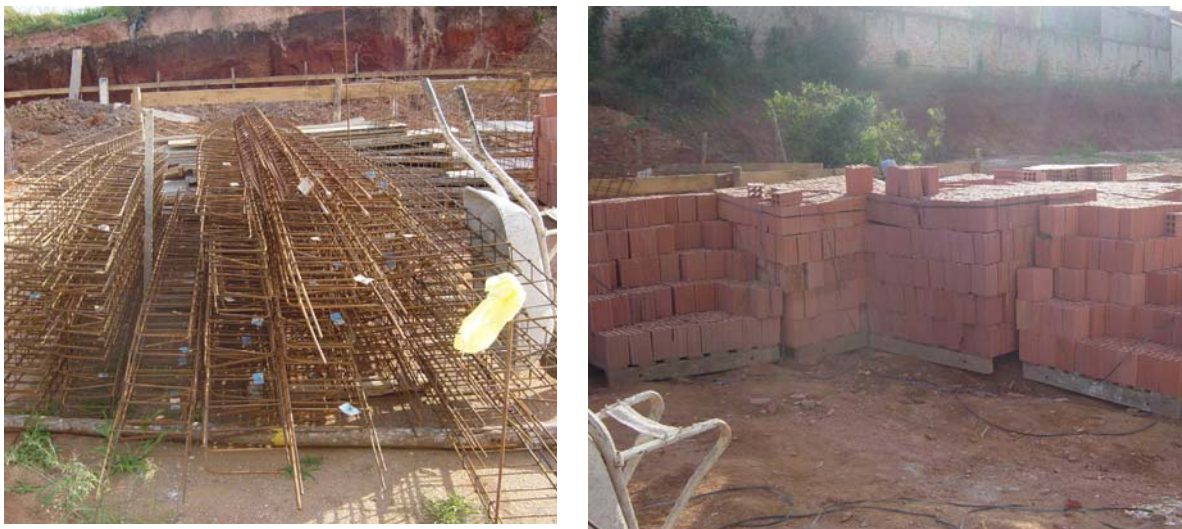
FIGURA 4.8 – ARMAZENAMENTO DOS MATERIAIS NO CANTEIRO DA OBRA
