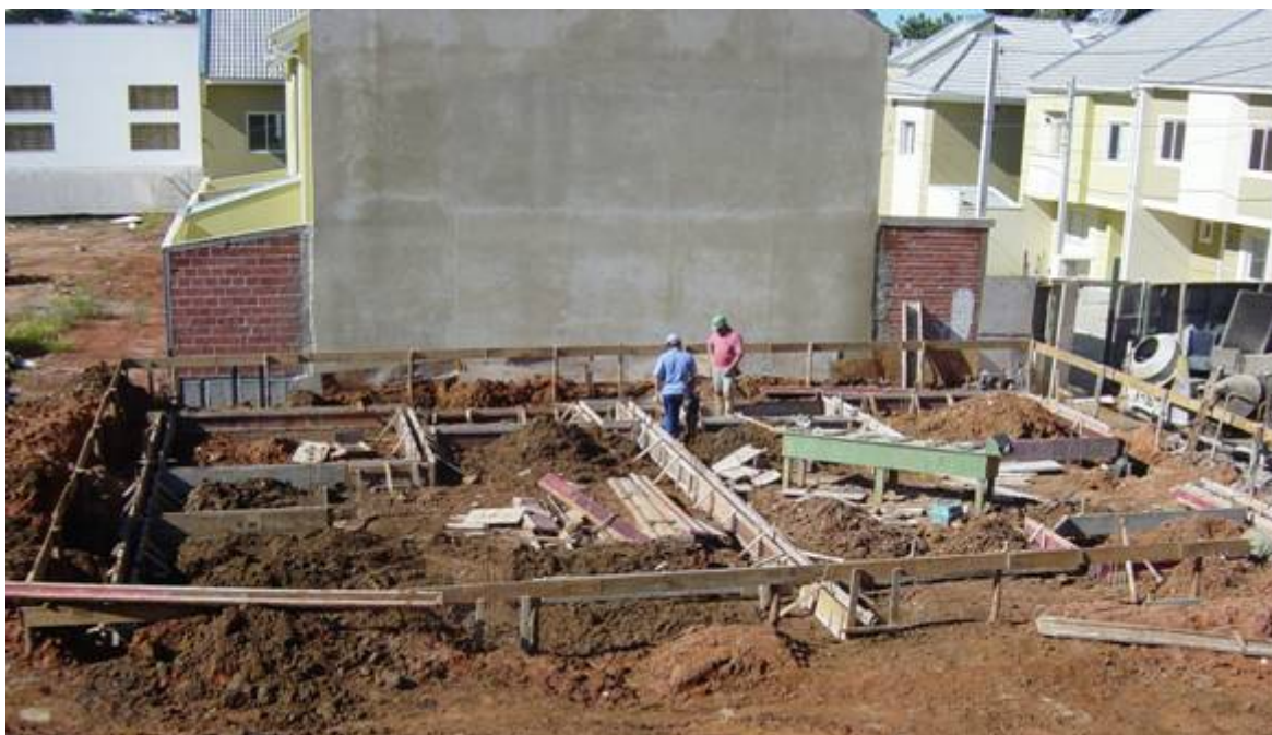
FIGURA 3.1 – FASE INICIAL DA CONSTRUÇÃO DOS DOIS SOBRADOS DA OBRA 1
