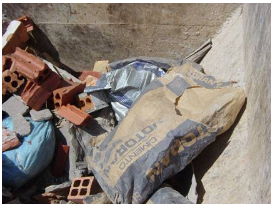
FIGURA 4.16 – RESÍDUOS DISPOSTOS NA CAÇAMBA ESTACIONÁRIA
