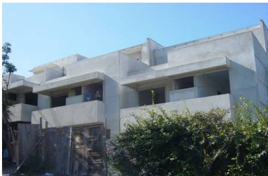
FIGURA 3.2 – VISTA DOS SOBRADOS DA OBRA 2
