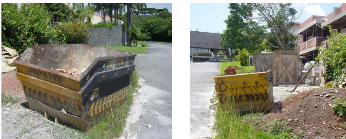
FIGURA 3.6 – LOCALIZAÇÃO DA CAÇAMBA ESTACIONÁRIA NA OBRA 2
