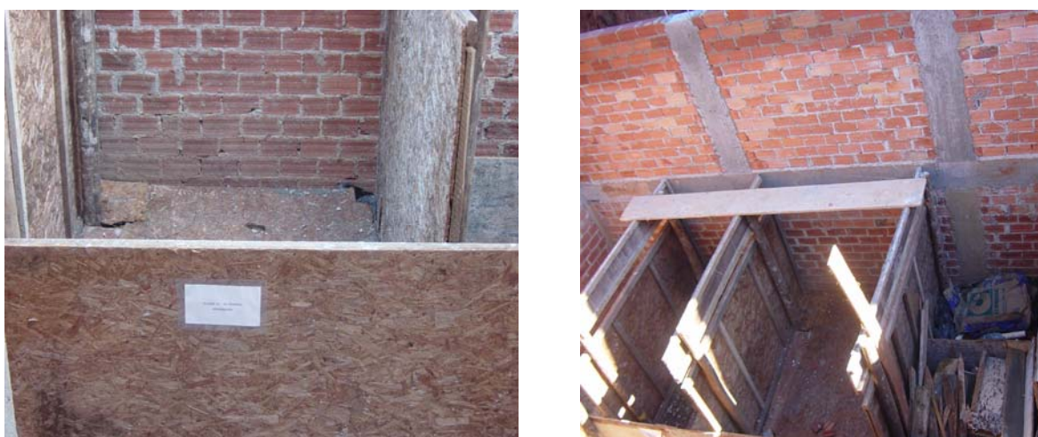
FIGURA 3.4 – BAIAS CONSTRUÍDAS NO CANTEIRO DE OBRA
