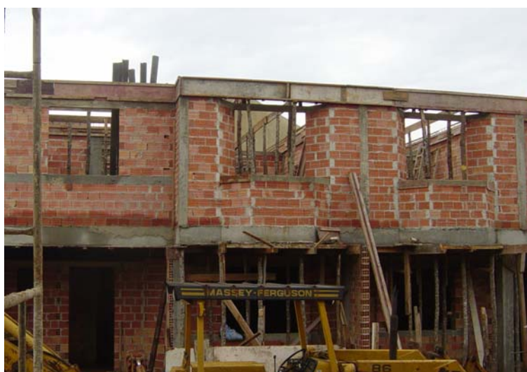
a) Vista da Obra 1
