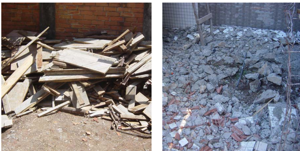
FIGURA 4.13 – MATERIAL DISPOSTO NO CANTEIRO DE OBRA 2
