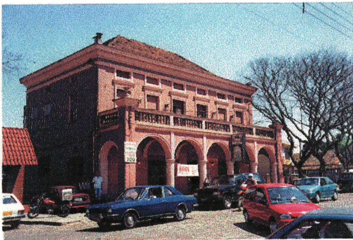
Fig.1 – Casa mandada construir pelo imigrante italiano Marco Mocellin em 1895. Hoje Restaurante Casa dos Arcos.
