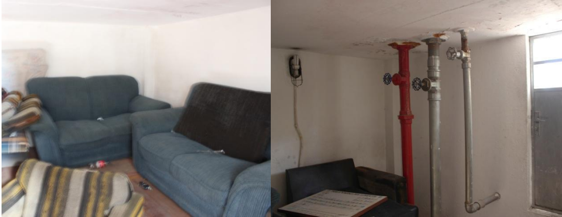
Figura 4.19. Sala de TV localizada no barrilete da edificação FONTE: AUTORA, 2012.
