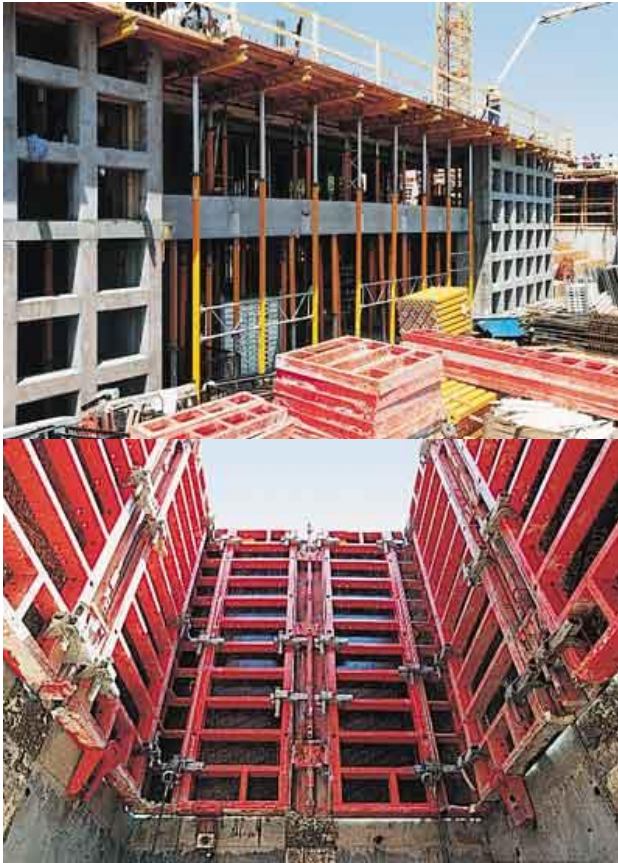
Figura 3.10 Obras Simmons Hall FONTE: PERI, -.
