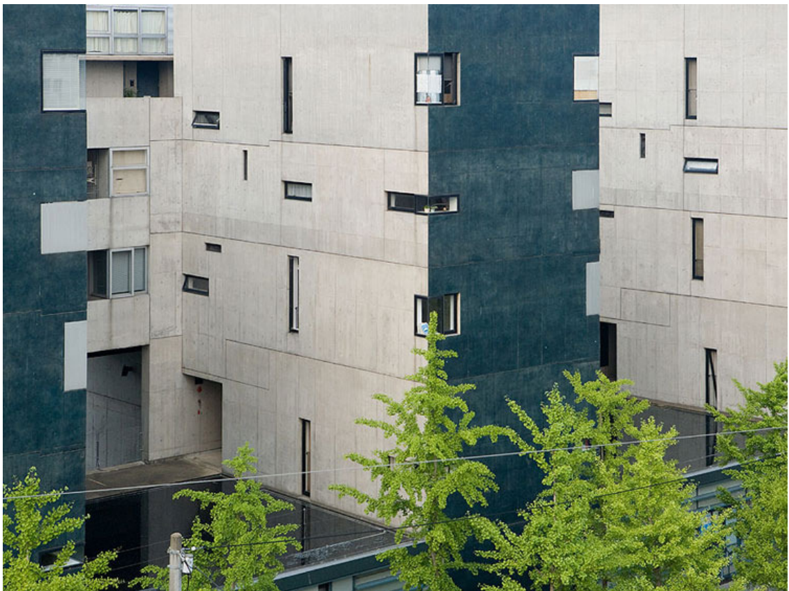
Figura 21: Espaços vazios inundados de água no edifício em Fukuoka. Fonte: stevenholl.com.
