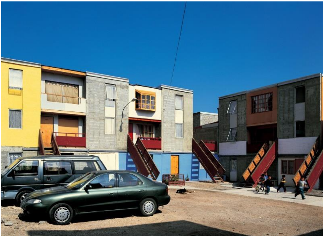
Figura 36: Foto do local, "praça" central entra as unidades. (FONTE: ELEMENTAL)
