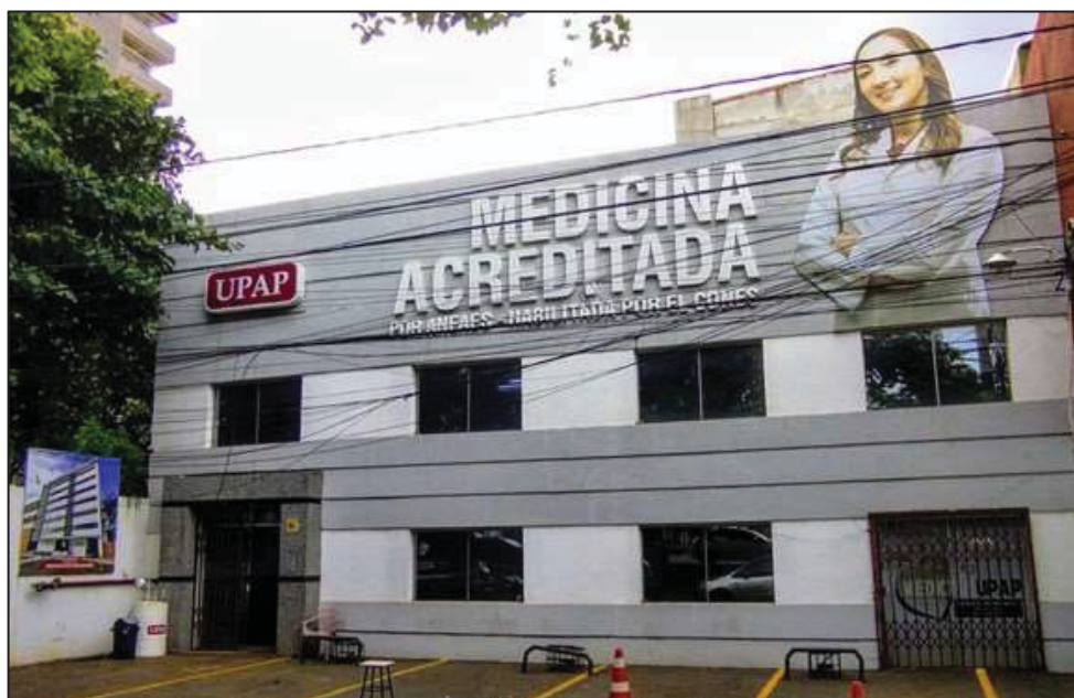
Figura 33 - Prédio da UPAP na Av. Alejo García
