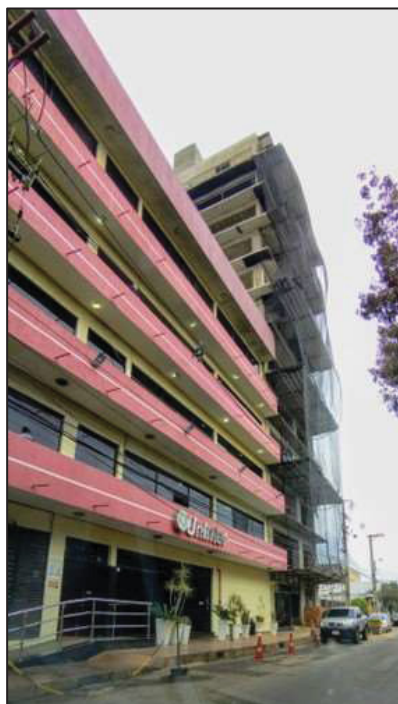
Figura 31 - Prédio principal da UNINTER e construção da ampliação
