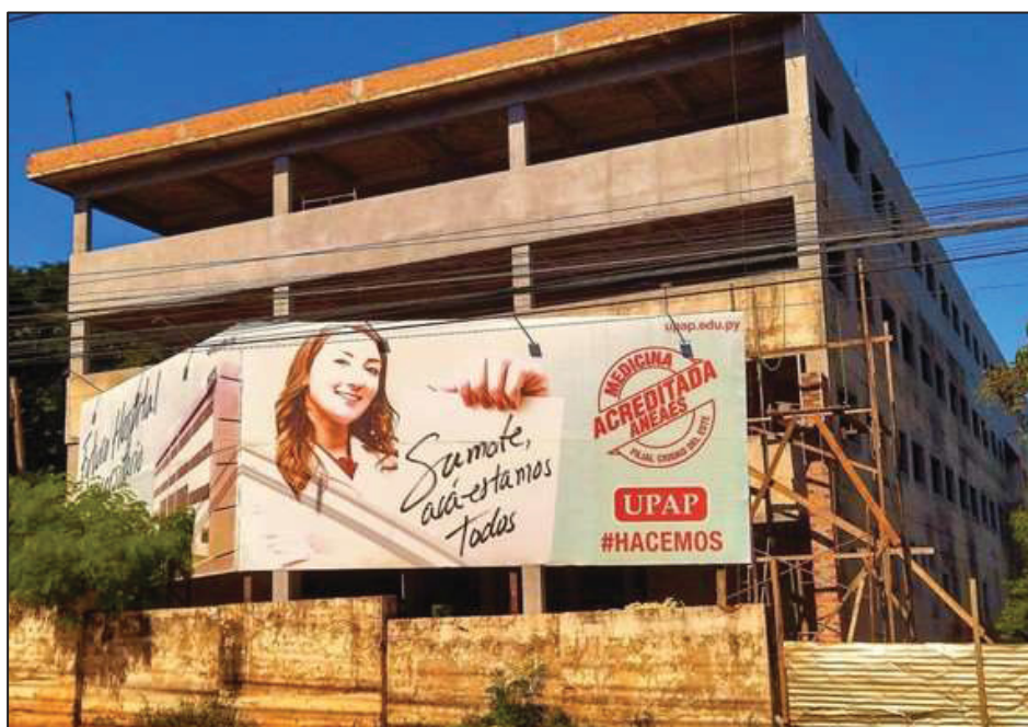
Figura 34 - Obra do hospital escola e outdoor com publicidade da UPAP no Km 10 em Ciudad del Este
