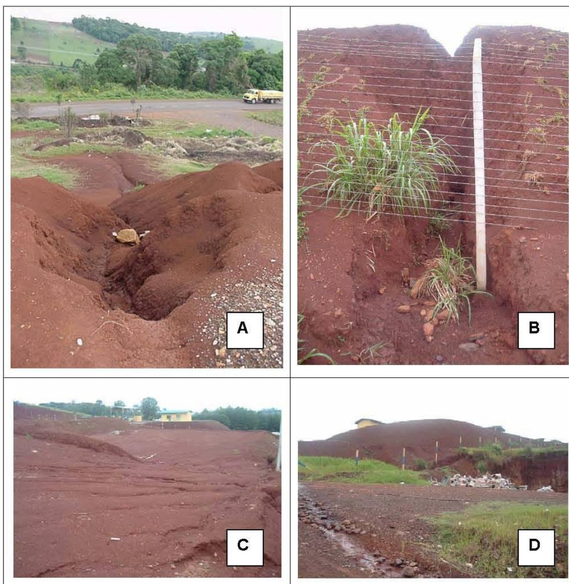
FIGURA 58 – ÁREAS DE CORTE E ATERRO APRESENTANDO VÁRIAS EROSÕES EM SULCOS.
