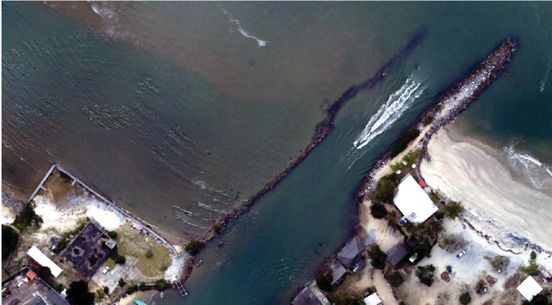
FIGURA 21 - ESTRUTURAS LOCALIZADAS NA DESEMBOCADURA DO CANAL DNOS
