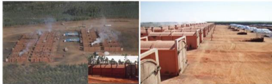
Figura 2 - PLANTA DE CARBONIZAÇÃO COM FORNOS DE ALVENARIA RETANGULARES
