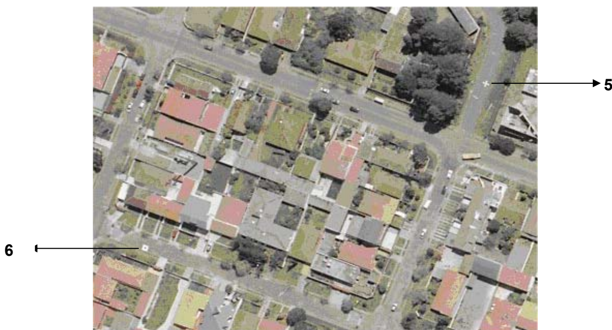
FIGURA 3.8 – PONTOS PRÉ-SINALIZADOS 5 E 6
