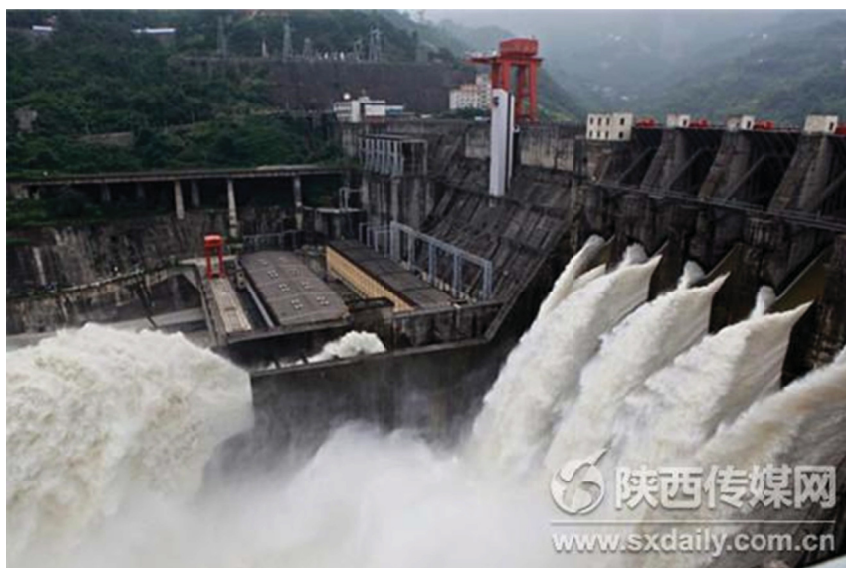
FIGURA 2.15 – VISTA DE JUSANTE DA OPERAÇÃO DO VERTEDOIRO DA HIDRELÉTRICA DE ANKANG -CHINA - PILARES ALARGADOS DE SEÇÃO Y
