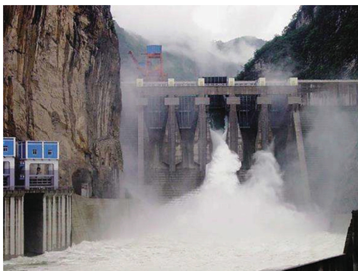
FIGURA 2.19 – VISTA DE JUSANTE DA OPERAÇÃO DO VERTEDOIRO DA HIDRELÉTRICA DE SUOFENGYING - CHINA - PILARES ALARGADOS DE SEÇÃO TRANSVERSAL X
