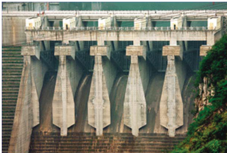
FIGURA 2.18 – VISTA DE JUSANTE DO VERTEDOIRO DA HIDRELÉTRICA DE SUO-FENGYING - CHINA - PILARES ALARGADOS DE SEÇÃO TRANSVERSAL X
