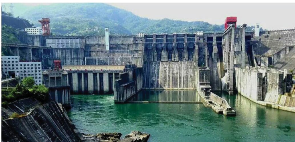
FIGURA 2.13 – VISTA DO VERTEDOURO DA HIDRELÉTRICA DE ANKANG - CHINA - PILARES ALARGADOS DE SEÇÃO Y
