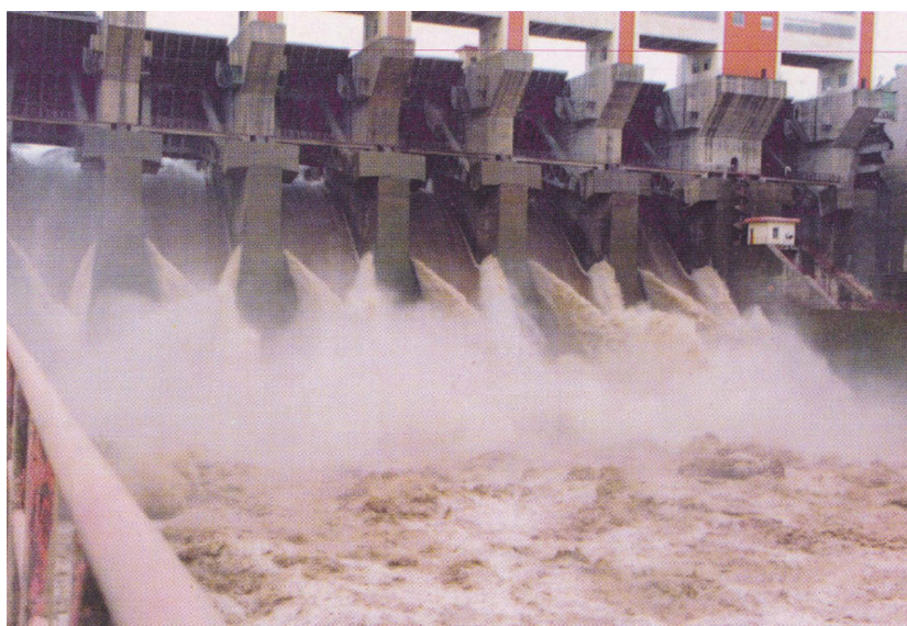
FIGURA 2.16 – VISTA DE JUSANTE DA OPERAÇÃO DO VERTEDOIRO DA HIDRELÉTRICA DE YANTAN -CHINA - PILARES ALARGADOS DE SEÇÃO Y
