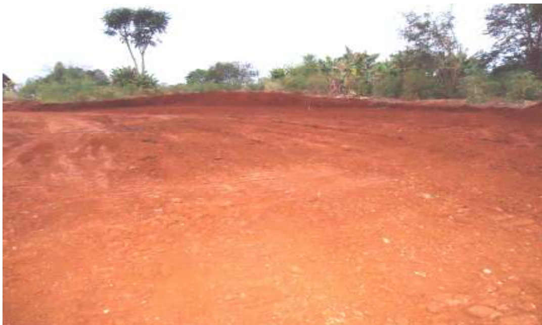
Figura 01: Terraplanagem do local da implantação da agroindústria (2011) Fonte: Registro da Cursista (2011)
