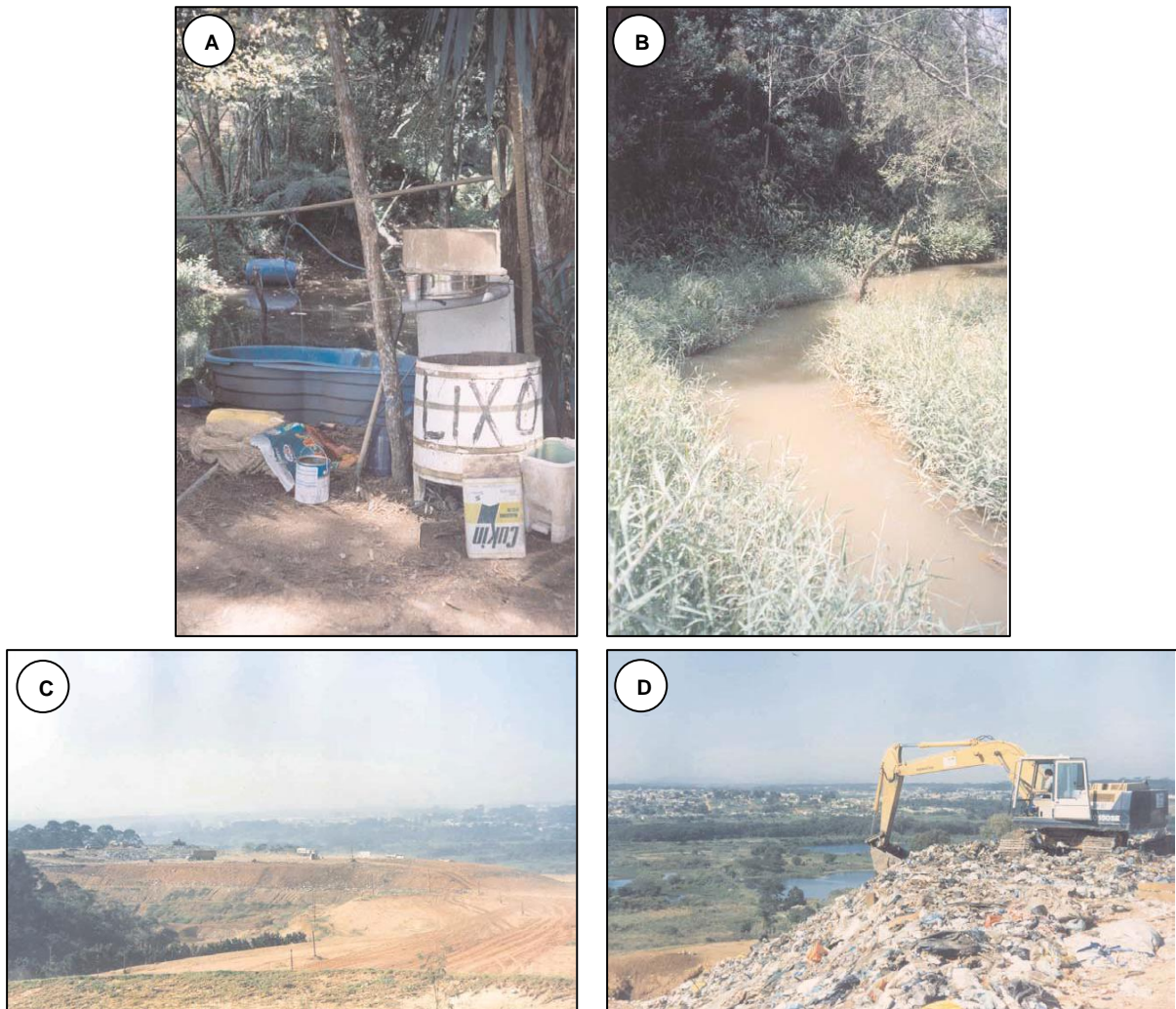
FIGURA 20 - IMAGENS HISTÓRICAS DAS APS DE CURITIBA. A. DEPÓSITO DE RESÍDUOS DE LAMENHA PEQUENA. B. TURBIDEZ DA ÁGUA À JUSANTE DE LAMENHA PEQUENA. C. VISTA DA PORÇÃO EM OPERAÇÃO DO ATERRO SANITÁRIO DA CAXIMBA. D. REGULARIZAÇÃO DO LIXO EM TALUDE DO ATERRO SANITÁRIO DA CAXIMBA. FONTE: MINEROPAR (2005)
