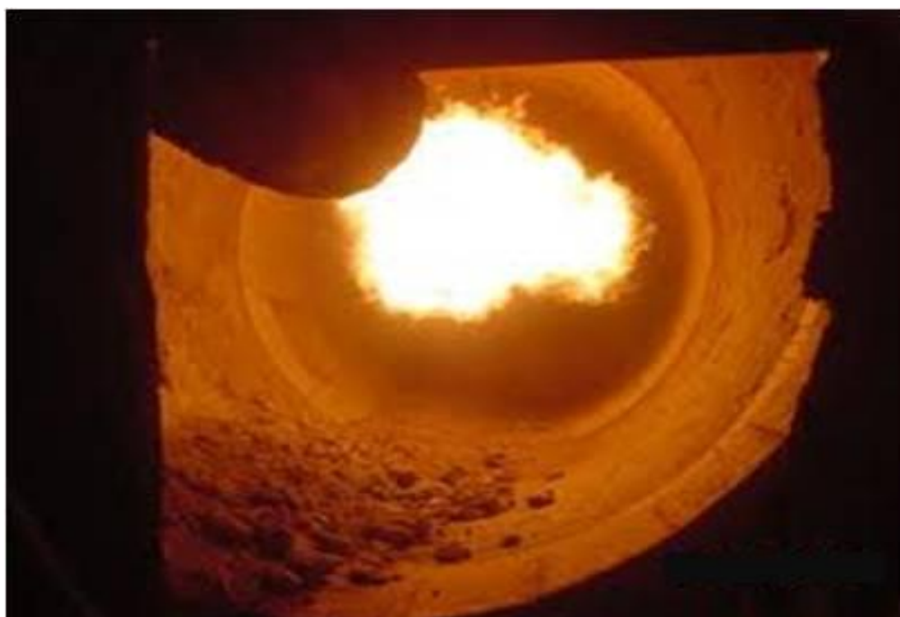
Figura 1: Fornos de cimento usam resíduos perigosos como substituto de energia.
