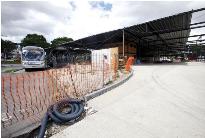
Figura 10 – Terminal Santa Cândida em reforma
