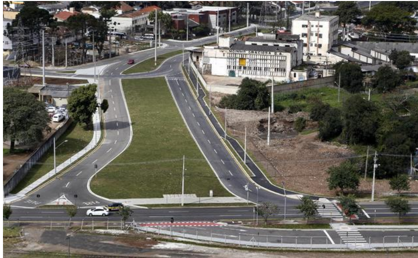
Figura 6 – Novo acesso a rodoferroviária
