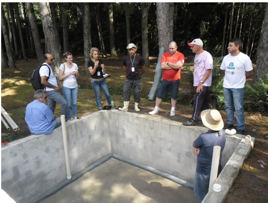
Figura. 02. Tanque de raízes, pronto para receber os materiais filtrantes.
