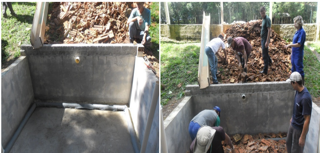
Figura 04 A. Colocação da Manta. Figura 04 B. Preenchimento com telhas.
