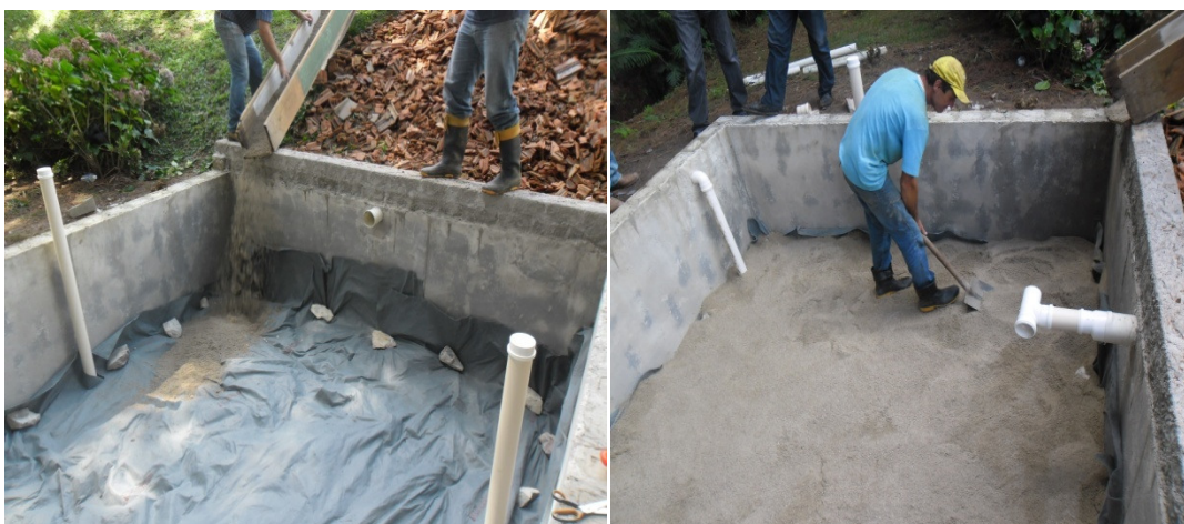
Figura 05 A. Colocação da manta. Figura 05 B. Preenchimento com areia.
