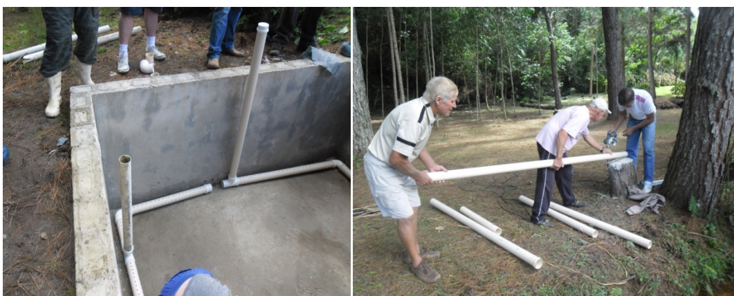
Figura 03 A. Encaixe dos canos
