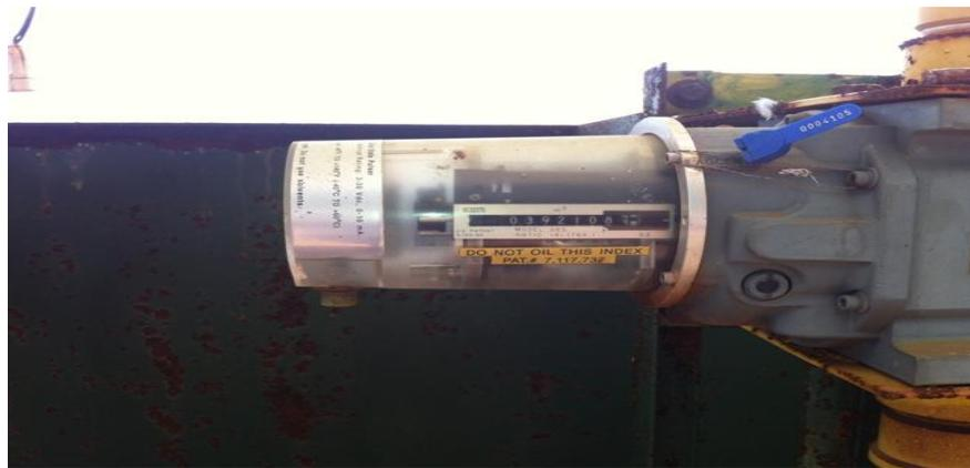
Figura 12 - Medidor de biogás
