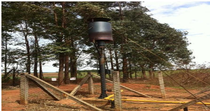
Figura 13 - Queimador de biogás tipo Flare
