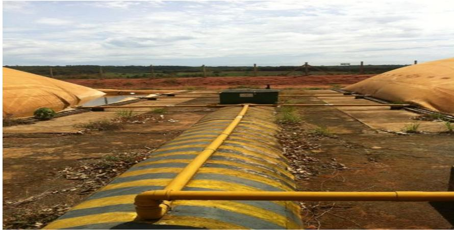
Figura 11 - Tubulação para transporte do biogás
