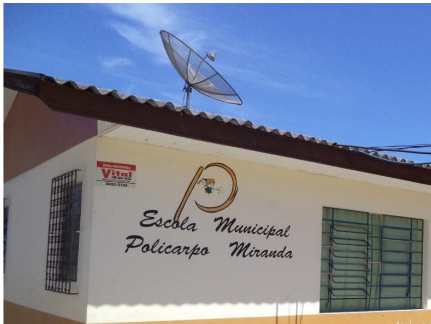
FIGURA 1. Escola Municipal Policarpo Miranda. (vista de frente)
