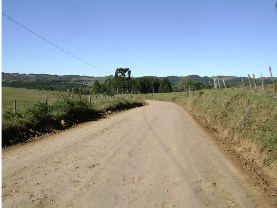
FIGURA 3 - CONDIÇÕES ATUAIS DA SC-458, VIA NÃO PAVIMENTADA FONTE: ENGEMIN (2012)
