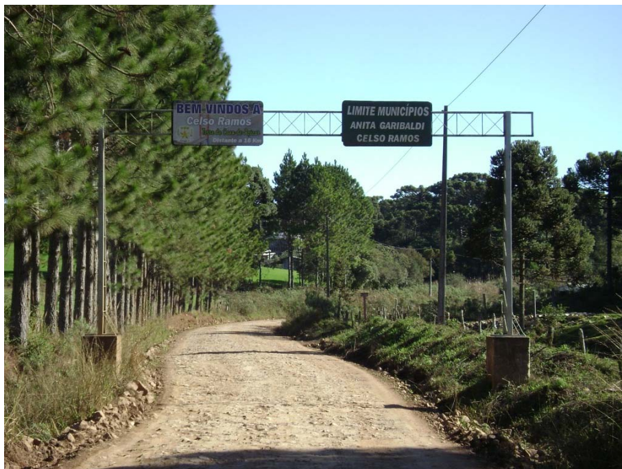
FIGURA 1 - RODOVIA SC-458 ENTRE OS MUNICÍPIOS DE CELSO RAMOS E ANITA GARIBALDI FONTE: ENGEMIN (2012)
