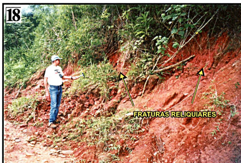
Foto 16 - Mourões em encostas com problema de instabilidade (rastejo). Foto 17 - Ponto de tiro "P.T." situado em área de suscetibilidade na (média alta) a erosão. Foto 18 - Escorregamento planar ao longo de fraturas relictas no solo/ saprolito.
