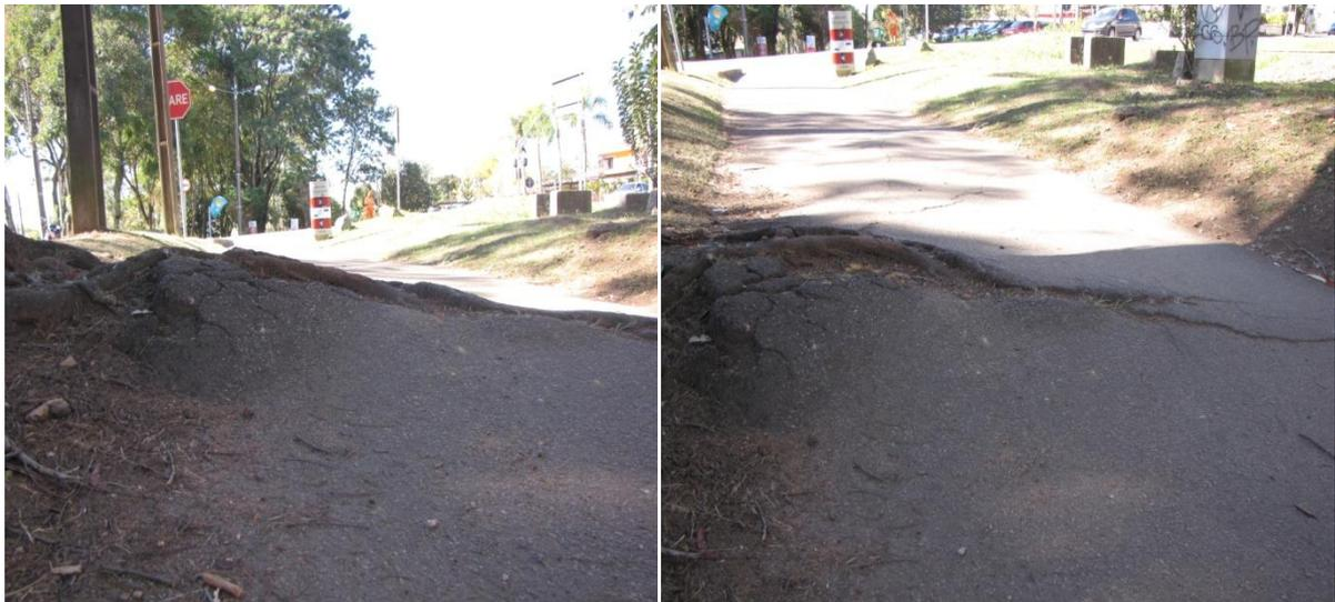
**Foto 07 e 08:** Esquina da Rua Itupava por onde segue a ciclovia no bairro Alto da XV: Próximo ao PolloShop, região de grande movimento e de intensa vida noturna. Os buracos e as raízes tomam conta da ciclovia. Em um determinado trecho adiante, existe um acampamento permanente de desvalidos.
